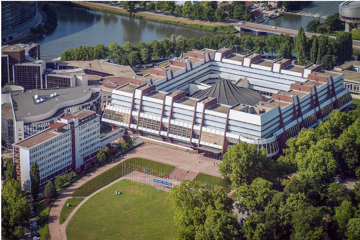
Figure 21. Vue aérienne du Palais de l'Europe, Strasbourg, 2003. Source : Wikimedia Commons. Architect : Henry Bernard. Photo : Conseil de l'Europe. Distribué sous licence Creative Commons Attribution 3.0 Unported .
