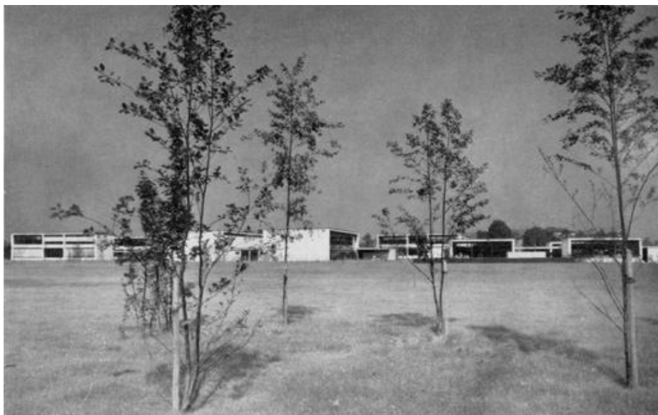
Figure 21 : école primaire pavillonnaire de Bâle (1953 - 1955)
