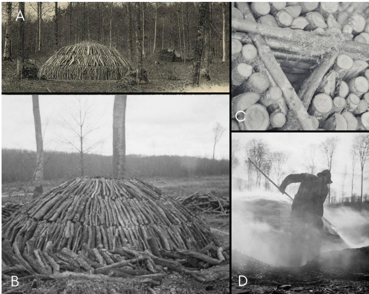
Figure 1 : Chaîne opératoire de la fabrication du charbon de bois : A/B) Montage d'une meule de bois en forêt ; C) cheminée centrale de forme triangulaire ; D) Charbonnier surveillant sa charbonnière. (Mucem, 4P2475/Ph.1937.1149/Ph.1937.1135/Ph.1941.11.3).
