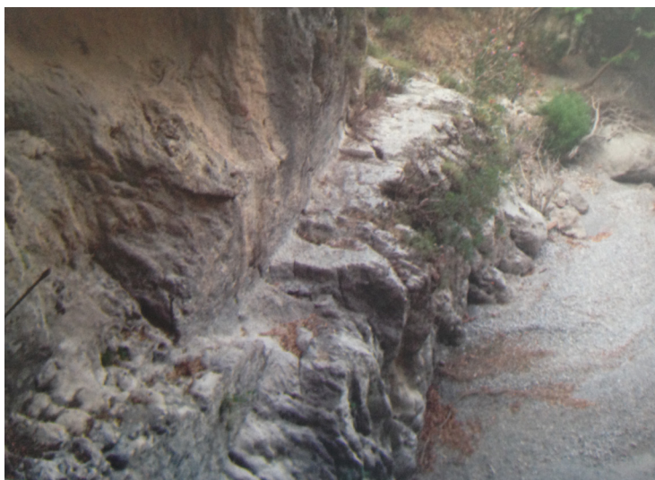
Figure 4. Aménagement d'une chaussée sur les rives du Nédon. Cl. Y. Pikoulas [PIKOULAS 2012, fig. 32].
