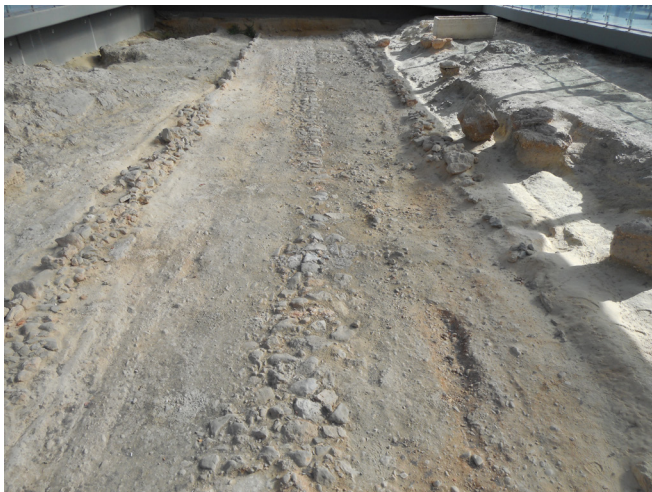
Figure 2. Route d'Athènes à Éleusis (Aigaléo) : chaussée en terre battue. Cl. A. Vorsanger.
