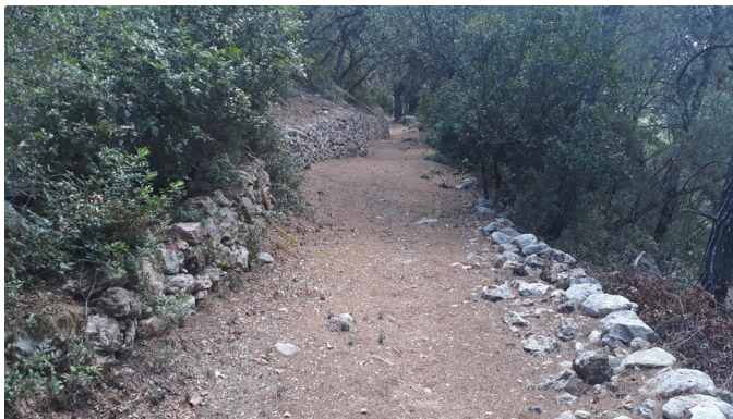
Figure 6. Soutènements sur une route menant au sanctuaire d'Asklépios à Épidaure. Cl. A. Vorsanger.
