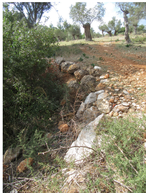
Figure 7. Soutènements de la route d'Oinoé (Agios Vlasios). Cl. A. Vorsanger.
