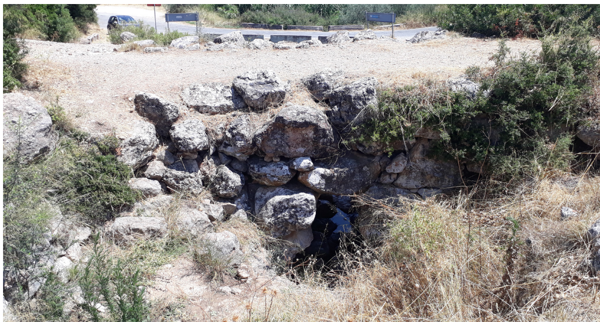
Figure 37. Le pont d'Arkadiko et la route asphaltée. Cl. A. Vorsanger.
