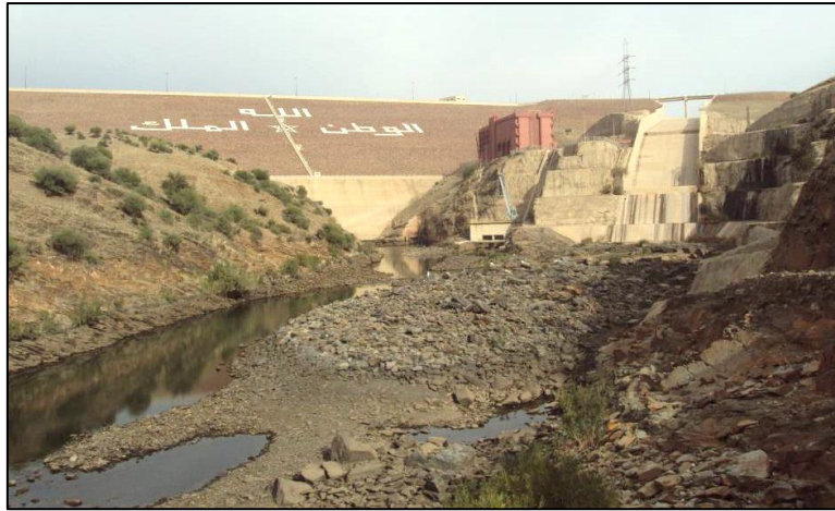
Photo 8-1 Barrage Ahmed El Hansali (ABHOER, 2014)
