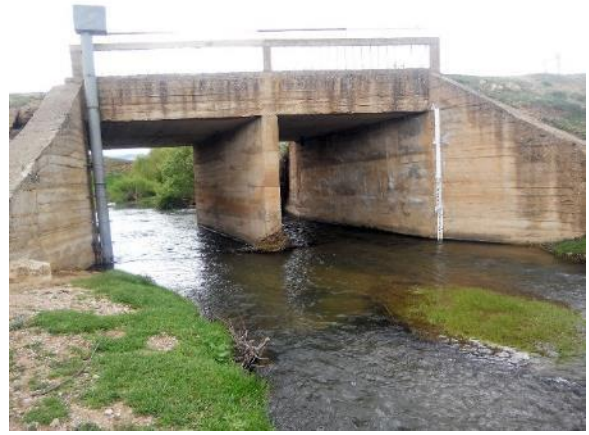
Station hydrométrique de Tamchachat sur l'Amengous
