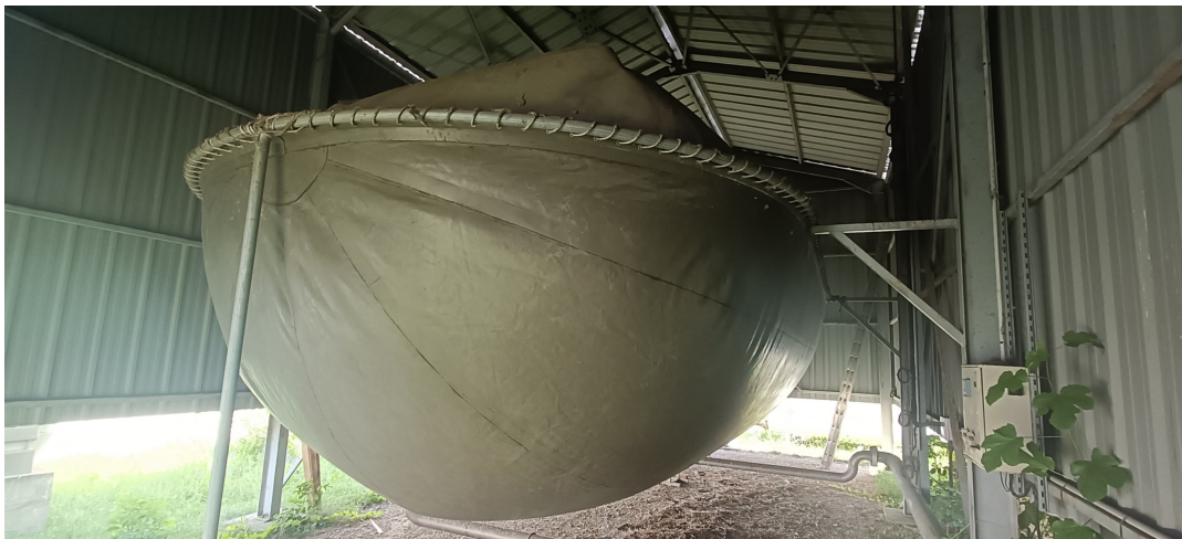
FIGURE 2.8. Gazomètre de 78 \text{ m}^3 du réseau de récupération d'hélium.
