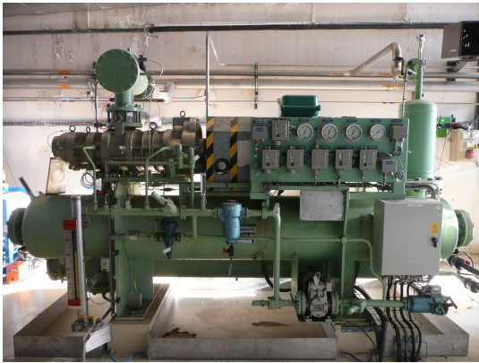
FIGURE 2.2. Compresseur à vis de la station 400W.
