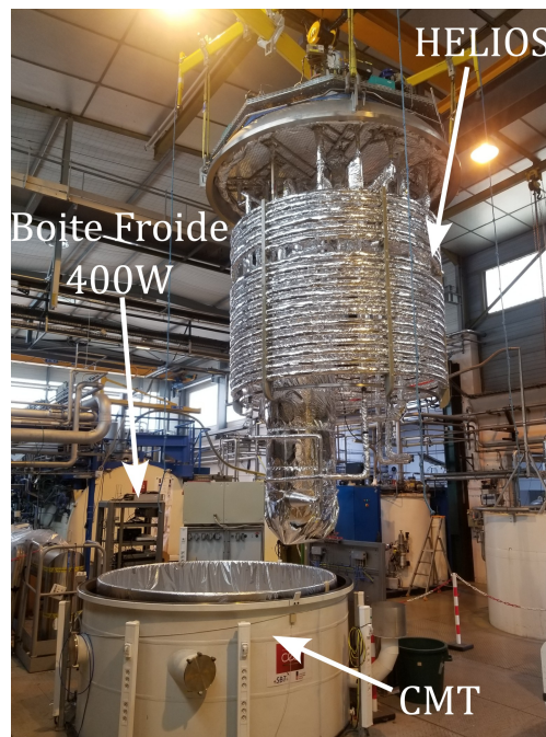
FIGURE 2.10. HELIOS lors de son installation dans le CMT.
