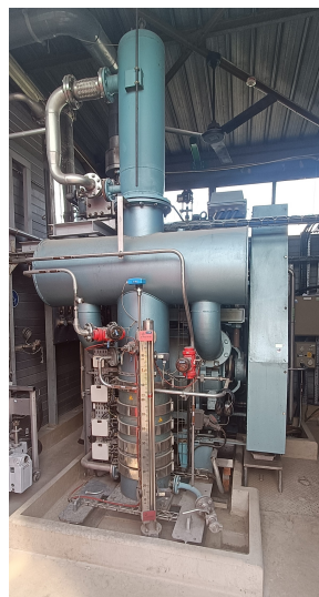
FIGURE 2.4. Pompe à anneau liquide de la station 400W.
