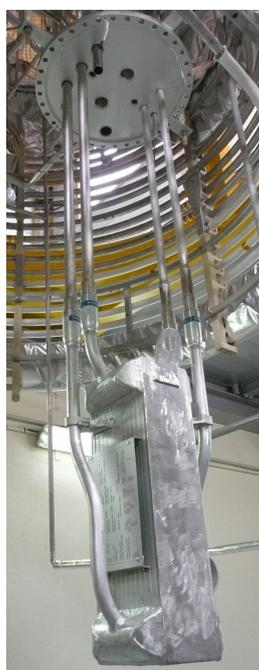
FIGURE 2.11. Bloc échangeur.
