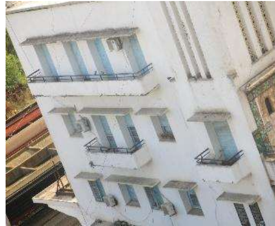
Figure 204 : Les balcons des logements de la gare de Skikda
