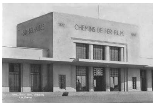
Figure 65 : Vue générale sur la gare ferroviaire de Sidi-Bel-Abbès 312
