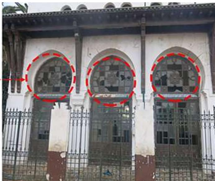
Figure 48 : État des vitres sur une des façades du buffet de la gare d'Oran, 2019
