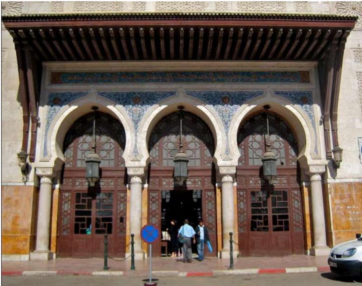
La gare d'Oran a été construite dans le style néo-mauresque. Les ouvertures des fenêtres sont en béton décoré en forme d'arcs outrepassés caractéristiques dans ce style ; les fenêtres sont en bois.
