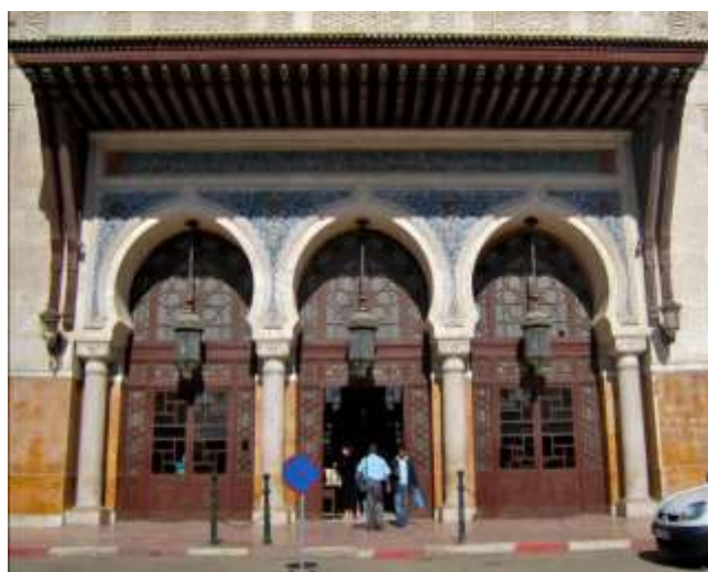
Figure 195 : Les portes entrées de la gare d'Oran 471
