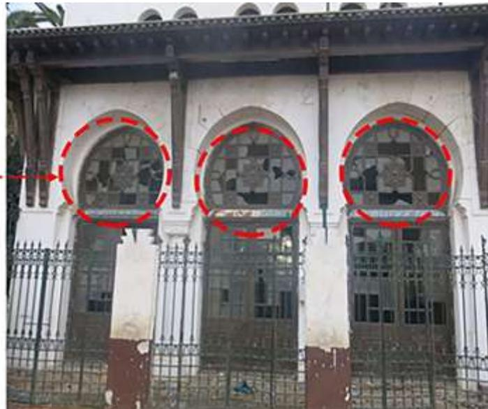
Figure 299 : État des vitres sur une des façades du buffet de la gare d'Oran, 2019
