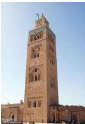
Figure 167 : Le minaret de la mosquée Koutoubia au Maroc
