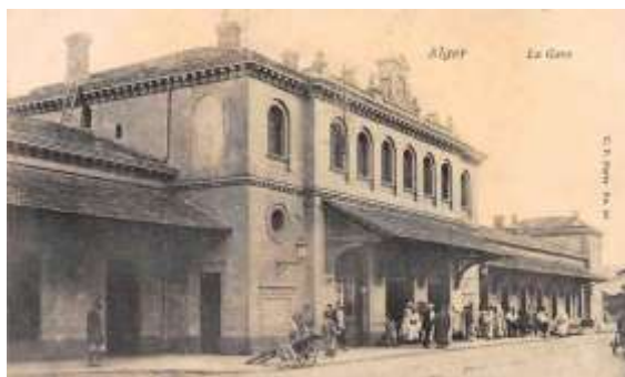
Figure 188 : La gare d'Alger avec son auvent 464
