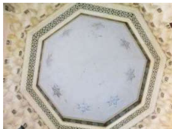
Figure 24 : Vue de dessous de la coupole centrale de la gare d'Oran 24 .
