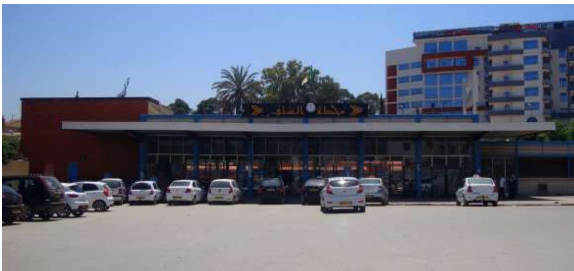
Figure 129 : Photo actuelle d'une vue d'ensemble de la gare de Chlef 414
