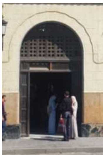
Figure 194 : Une des portes de l'entrée principale de la gare d'Alger 472
