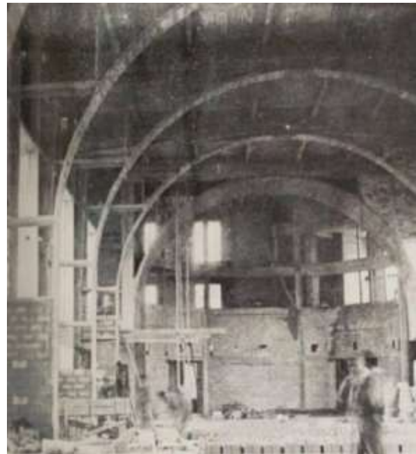
Figure 282 : Photo d'intérieur montrant le chantier de la réalisation de la gare d'Annaba 574
