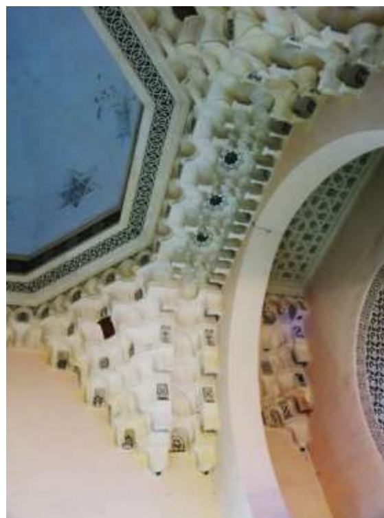
Figure 239 : Détails décoratifs d'un arc à muqarnas et de la coupole centrale de la gare d'Oran 524
