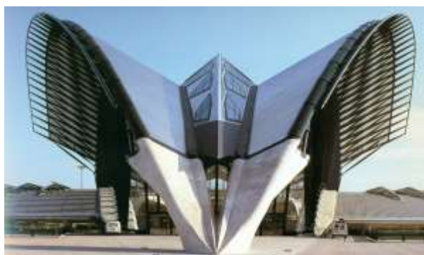
Figure 150 : Vue générale de la gare de Lyon-Saint-Exupéry en France 441
