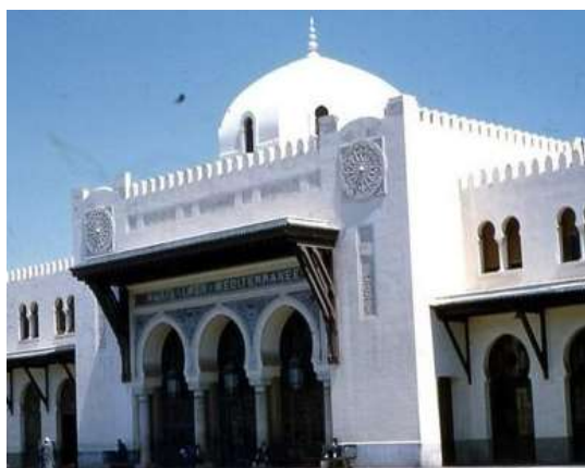
Figure 37 : Vue extérieure de la coupole de la gare d'Oran
