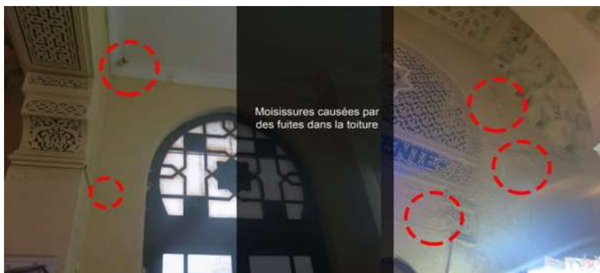
Figure 50 : État de quelques cloisons au niveau de la salle des pas perdus et de la salle d'attente de la gare d'Oran, 2019 55
