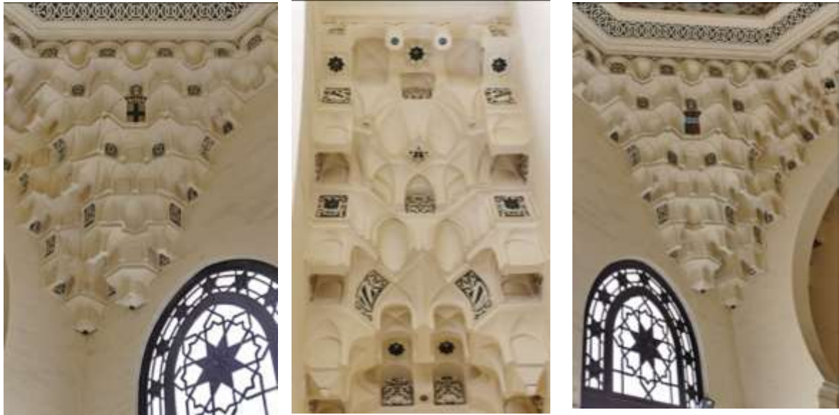
Figure 242 : Photos des arcs à muqarnas de la gare d'Oran 528
