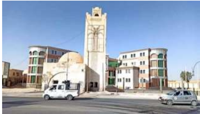
Figure 327 : La gare d'El-Oued, dont une partie a été sauvée par une association locale 730
