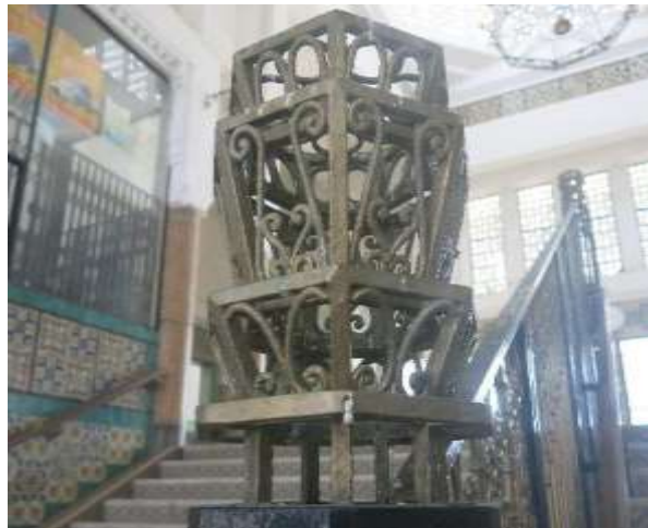
Figure 265 : Vue sur le travail de ferronnerie sur la main courante de l'escalier central de la gare de Skikda
