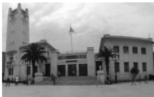
Figure 64 : Vue générale sur la mairie de Mostaganem 311
