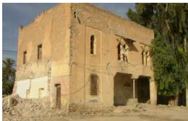
Figure 313: Photo de la gare de Tolga peu avant sa démolition 613
