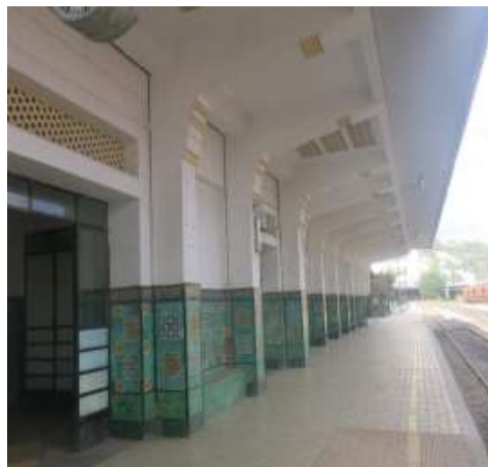
Figure 192 : L'auvent en béton et en verre du côté des voies de la gare de Skikda 468
