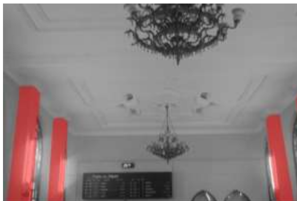
Figure 40 : En rouge, les poteaux maintenant la toiture dans la salle d'attente de la gare d'Oran 42
