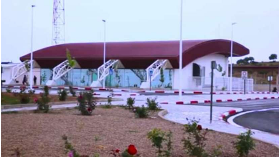
Figure 146 : Vue générale de la gare de Saïda — Réalisation de 2016 ANERSIF 436
