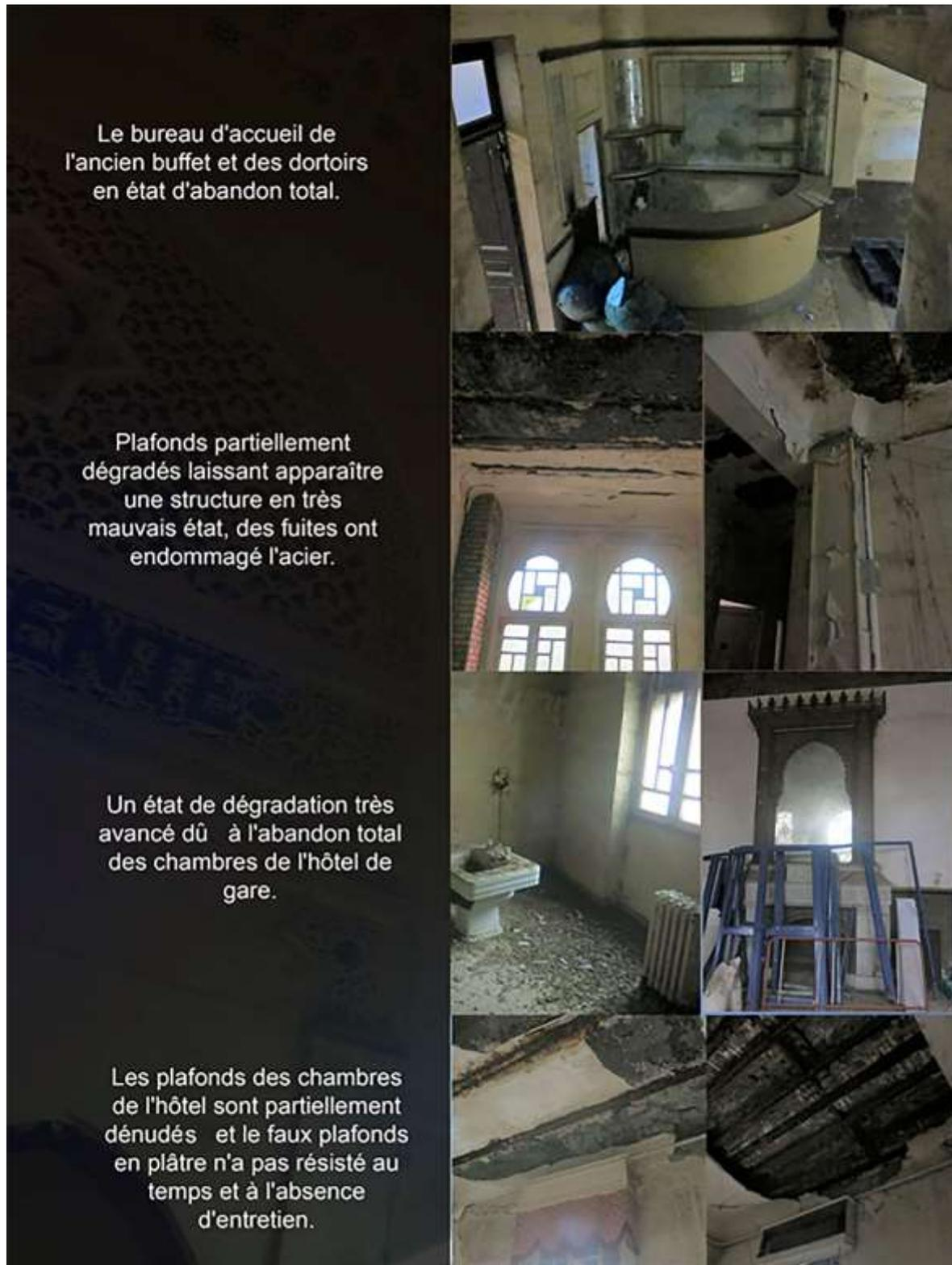
Figure 302 : État de l'intérieur du bâtiment du buffet et du dortoir de la gare d'Oran, 2019<sup>602</sup>
