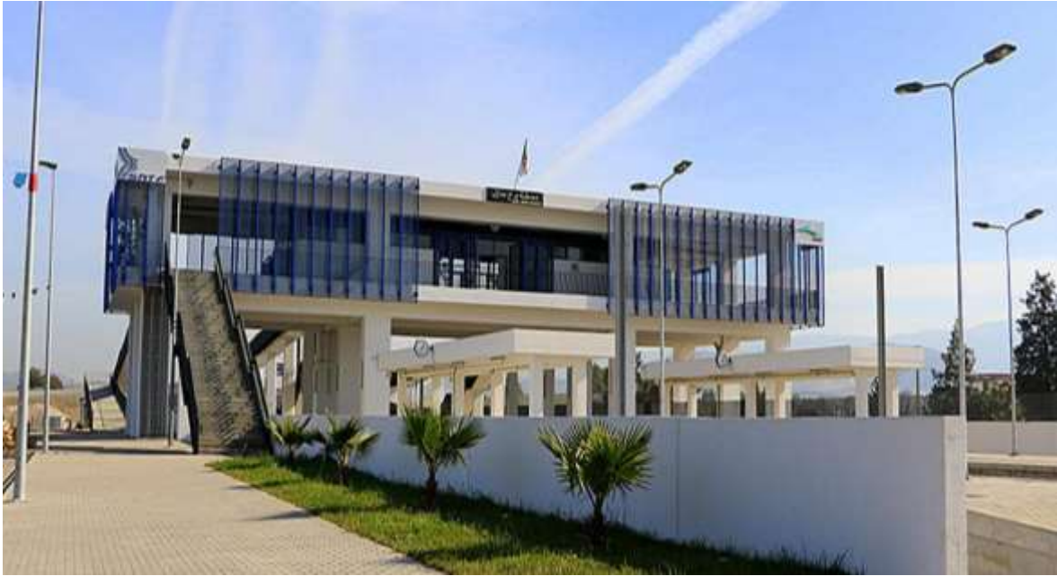
Figure 144 : Vue générale de la gare de Bordj Menâïel — Réalisation de 2016 ANERSIF 434
