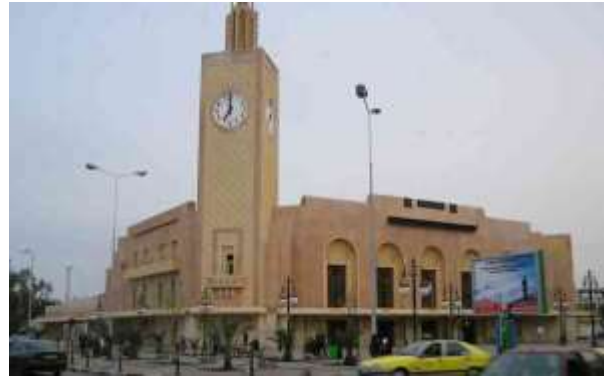
Figure 356 : La gare d'Annaba avant la rénovation de 2018 765
