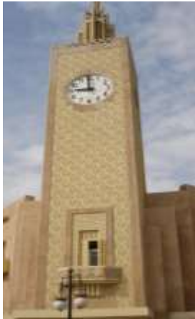
Figure 202 : Un des deux balcons de la gare d'Annaba
