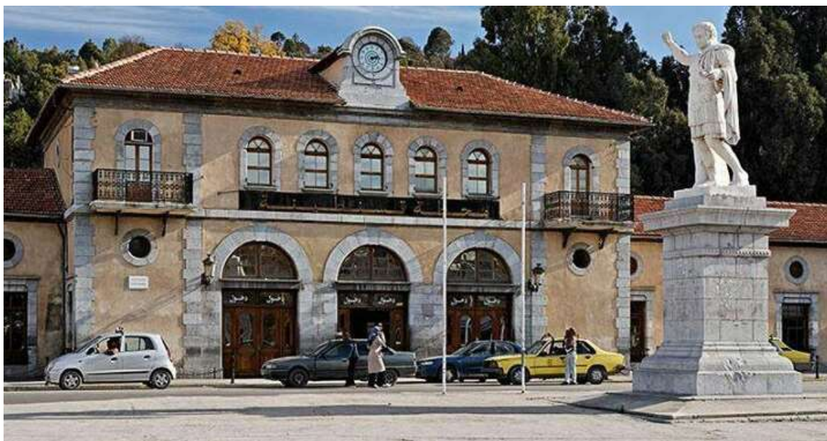
Figure 72 : Vue générale de la gare de Constantine — Réalisation de 1868, Compagnie PLM 341
