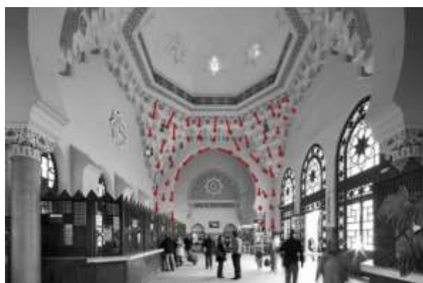
Figure 279 : Répartition en rouge des charges depuis la coupole de la gare d'Oran 569
