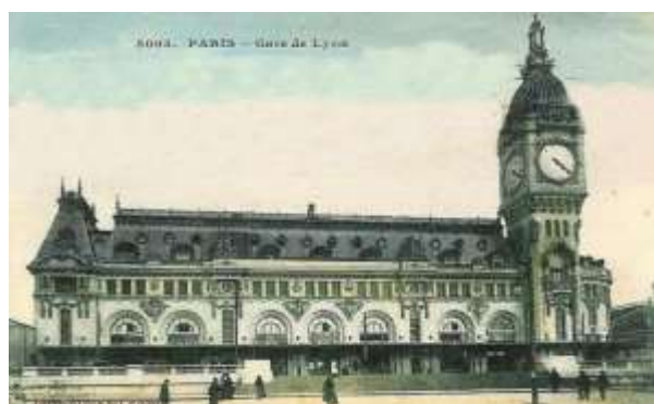
Figure 70 : Vue générale de la gare de Lyon à Paris, en France 338
