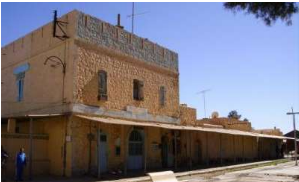
Figure 113 : Vue générale de la gare de Colomb-Béchar, Compagnie franco-algérienne_Vers 2007 388
