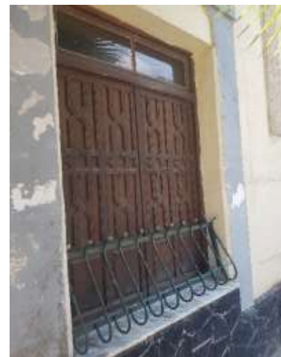
Figure 233 : Détail sur la boiserie actuelle des fenêtres de la gare d'Alger 517
