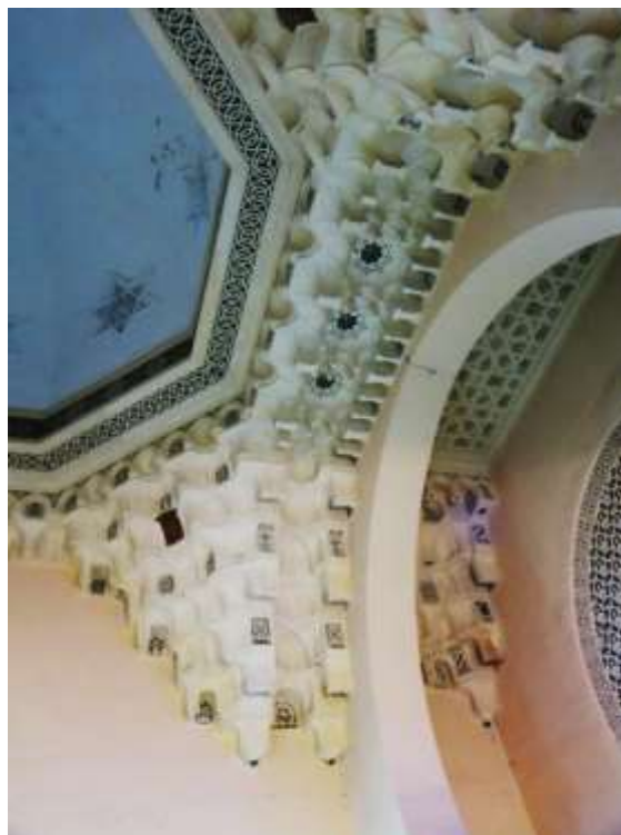
Figure 239 : Détails décoratifs d'un arc à muqarnas et de la coupole centrale de la gare d'Oran 524
