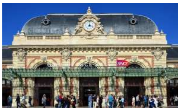
Figure 71 : Vue générale de la gare de Nice-Ville en France 339
