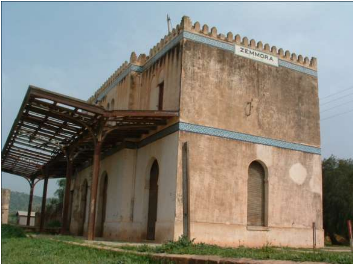
Figure 107 : Vue générale de la gare de Zemmora, Compagnie PLM 384
