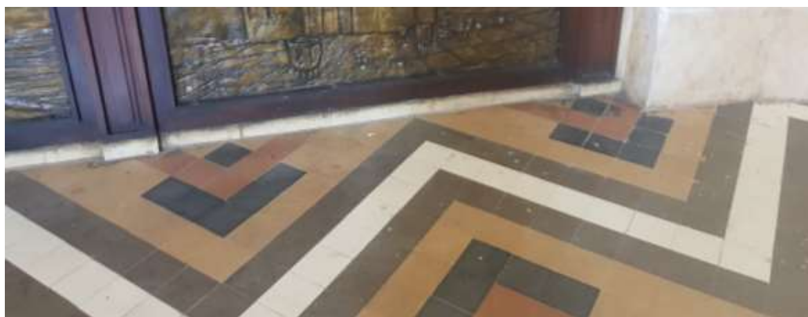
Figure 256 : Revêtement du sol de la gare d'Annaba 544
