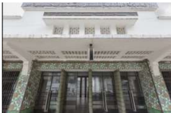
Figure 196 : La porte d'entrée de la gare de Skikda 475
