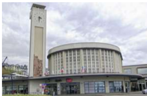
Figure 121 : Vue générale de la gare de Brest, en France 402
