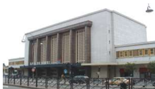
Figure 120 : Vue générale de la gare du Havre en France 401
