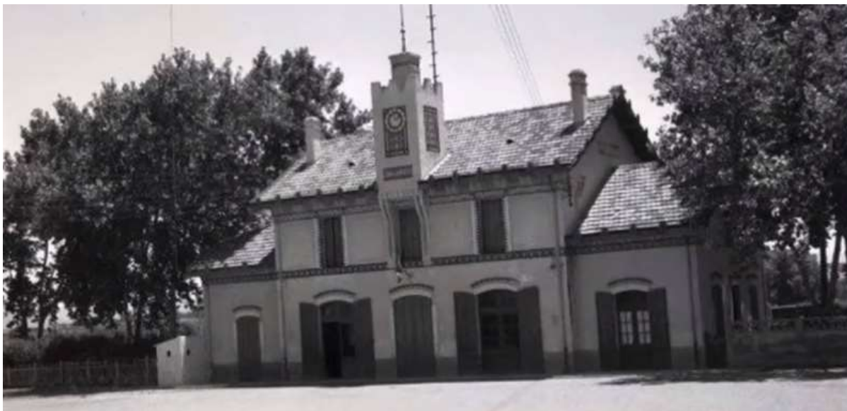
Figure 90 : Vue générale de la gare de Maghnia, Photo de 1923, Compagnie PLM 356
