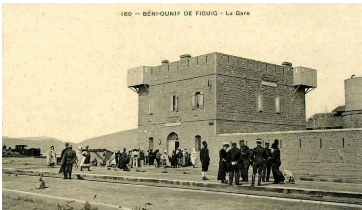
Figure 108 : Vue générale de la gare Beni Ounif — Réalisation de 1904, Compagnie franco-algérienne 385
