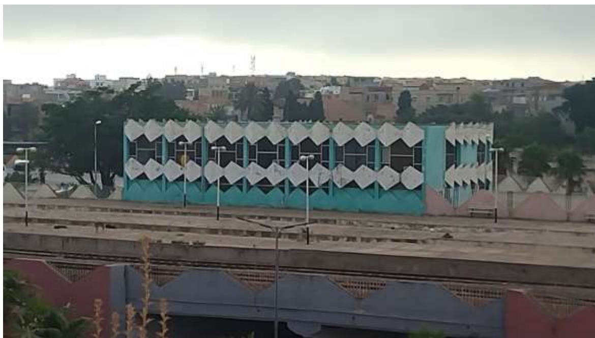
Figure 142 : Vue générale de la gare de Aïn Témouchent — Réalisation de 1980 ,SNTF 430
