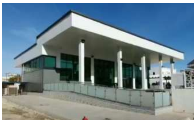
Figure 362 : La nouvelle gare pour grandes lignes d'Oran, côté voies, 2020 774
