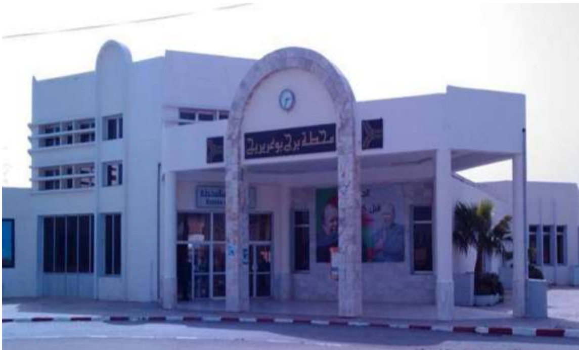
Figure 141 : Vue générale de la gare de Bordj Bou Arreridj — Réalisation de 2010, SNTF 429
