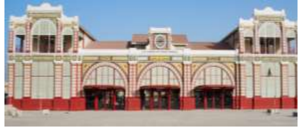
Figure 139 : Vue générale de la gare de Dakar au Sénégal 426
