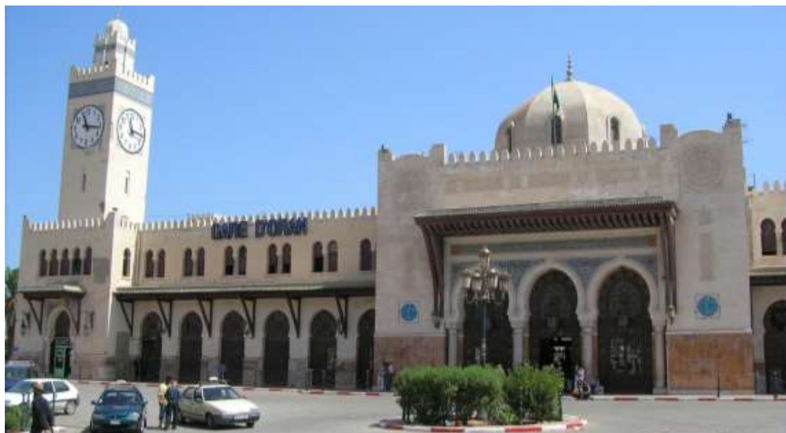
Figure 100 : Vue générale sur la gare centrale d'Oran — Architecte Albert Ballu, Compagnie PLM 373
