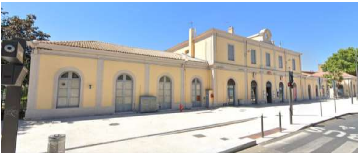
Figure 156 : Vue générale sur la gare d'Aix-en-Provence en France, Compagnie PLM 449
