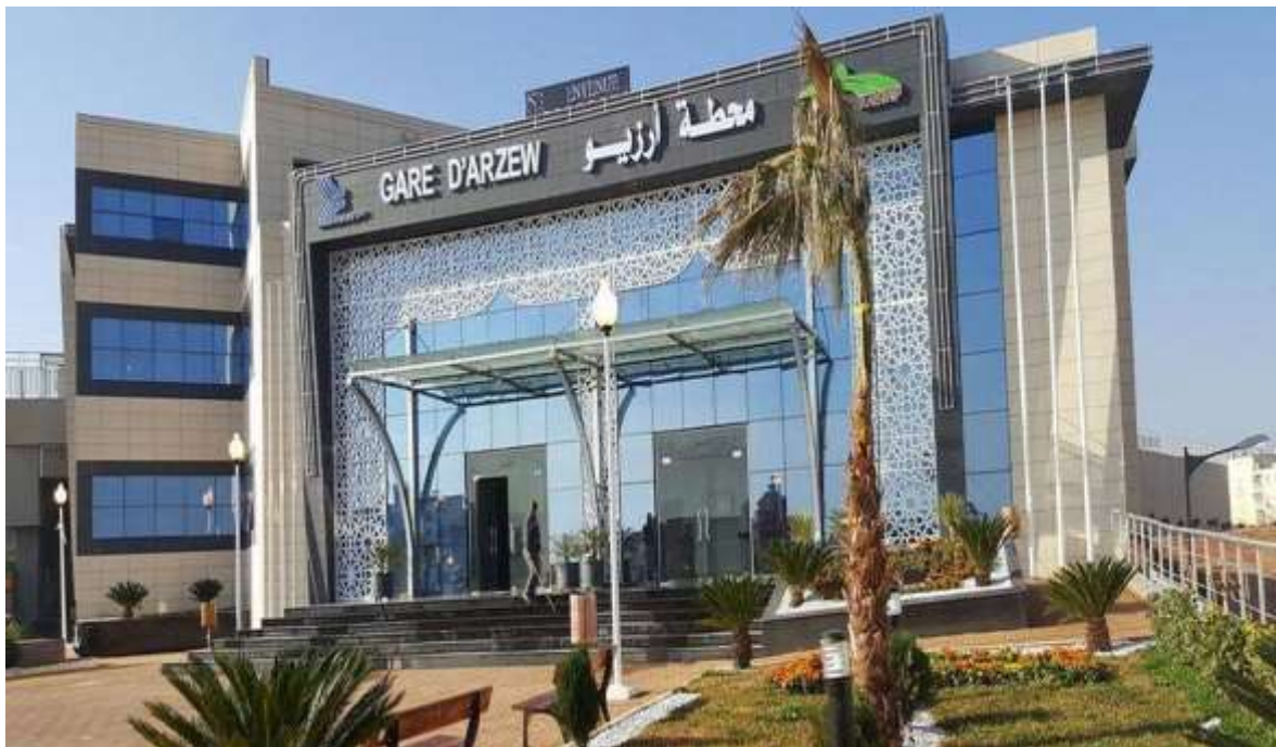
Figure 145 : Vue générale de la gare d'Arzew — Réalisation de 2017 ANERSIF 435
