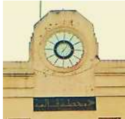
Figure 82 : Fronton à pans de la gare de Guelma
