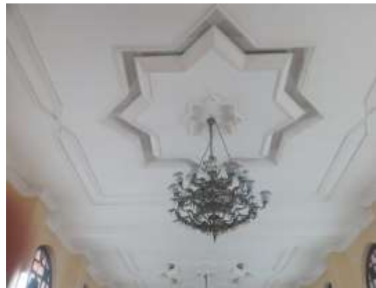
Figure 249 : Le plafond de la salle d'attente de la gare d'Oran 536
