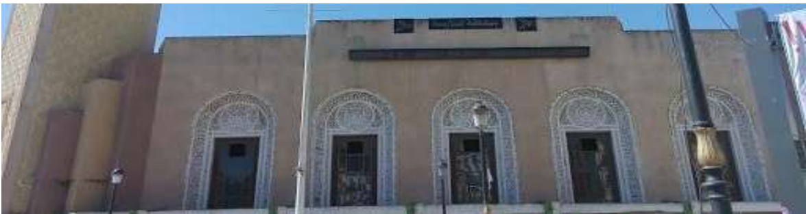
Figure 200 : Aperçu sur les ouvertures de la gare d'Annaba
