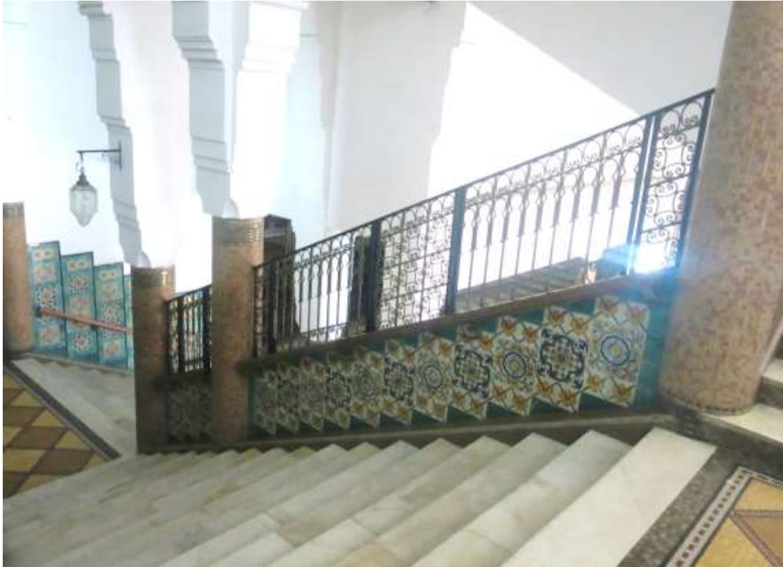
Figure 270 : décoration des escaliers de la gare de Skikda avec des motifs floraux et des dessins géométriques, poteaux recouverts de mosaïque, marches en marbre 558
