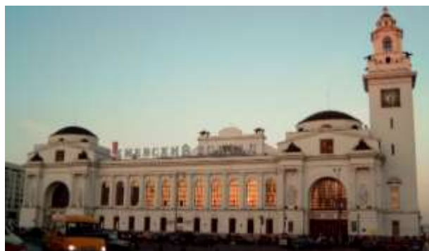
Figure 69 : Vue générale sur la gare de Kiev à Moscou, en Russie 337
