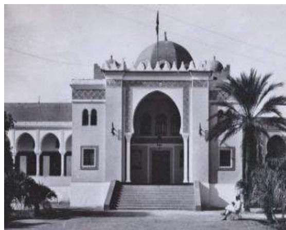
Figure 57 : Vue sur l'entrée du casino à Biskra 296
