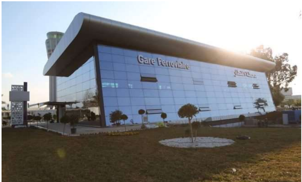
Figure 147 : Vue de la gare de l'aéroport international Houari Boumédiène à Alger — Réalisation de 2019 ANERSIF 437
