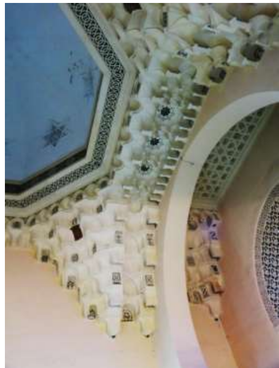
Figure 22 : Détails décoratifs d'un arc à muqarnas et de la coupole centrale de la gare d'Oran 21
