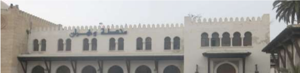
Figure 199 : Aperçu sur les ouvertures de la gare d'Oran
