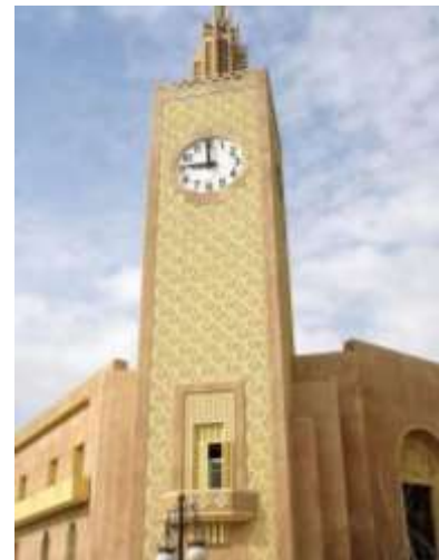
Figure 166 : La tour d'horloge de la gare d'Annaba
