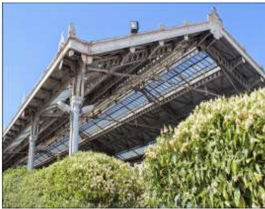
Figure 185 : Première vue sur la halle de la gare d'Oran
