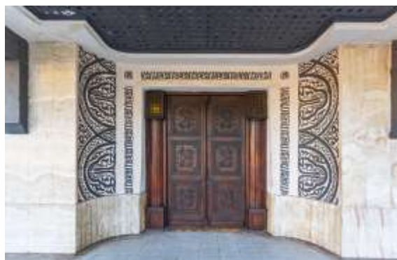
Figure 197 : La porte d'entrée de la gare d'Annaba 476
