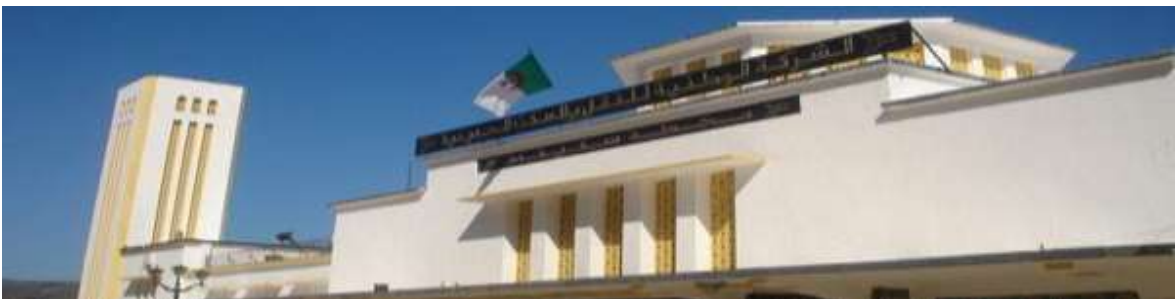
Figure 201 : Aperçu sur les ouvertures de la gare de Skikda
