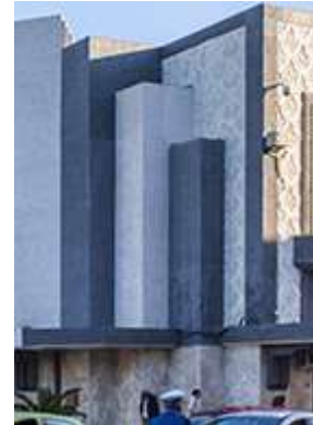
Figure 99 : Traitement d'angle de la gare d'Annaba
