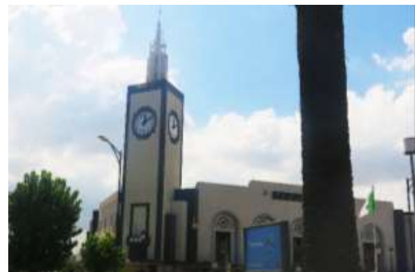
Figure 357 : La gare d'Annaba après la rénovation de 2018 766
