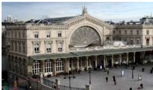
Figure 85 : La gare de l'Est à Paris, en France 349
