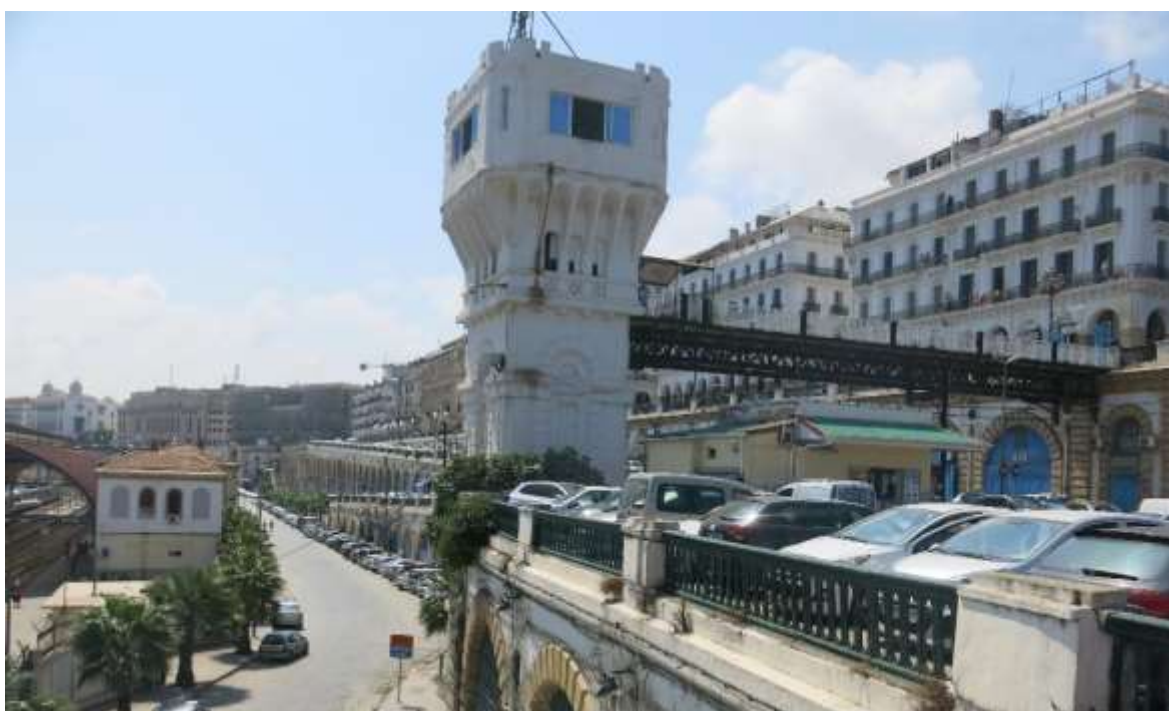
Figure 46 : Ascenseur public pour rejoindre le square Port-Saïd situé sur la place de la gare d'Alger 275
