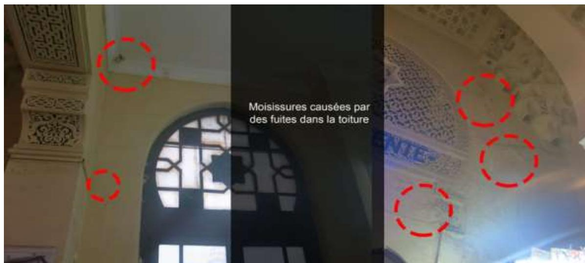
Figure 50 : État de quelques cloisons au niveau de la salle des pas perdus et de la salle d'attente de la gare d'Oran, 2019<sup>55</sup>
