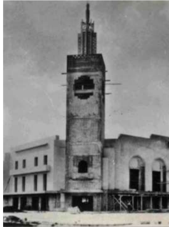
Figure 283 : Photo d'extérieur montrant le chantier de la réalisation de la gare d'Annaba 576
