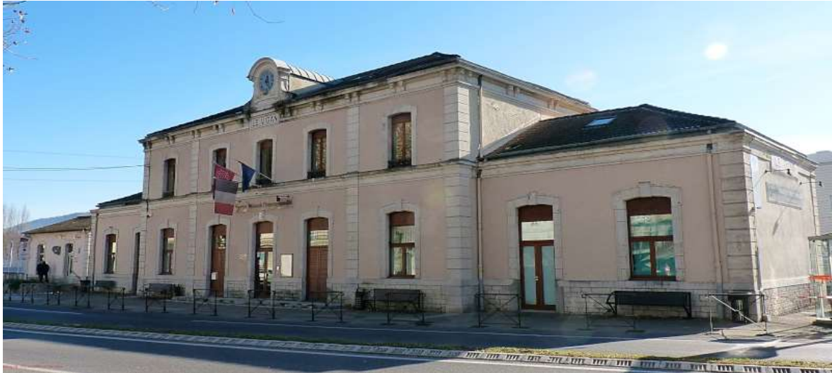
Figure 155 : Vue générale sur la gare du Vigan dans le Gard en France, Compagnie PLM 448
