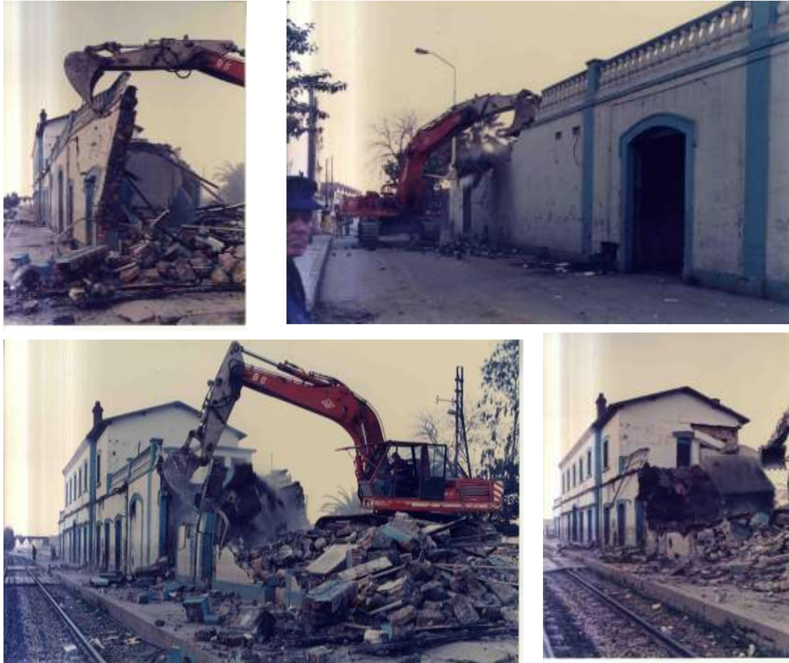
Figure 337 : Photos de démolition de la gare de la ville d'El Harrach, ex Maison-Carrée 746
