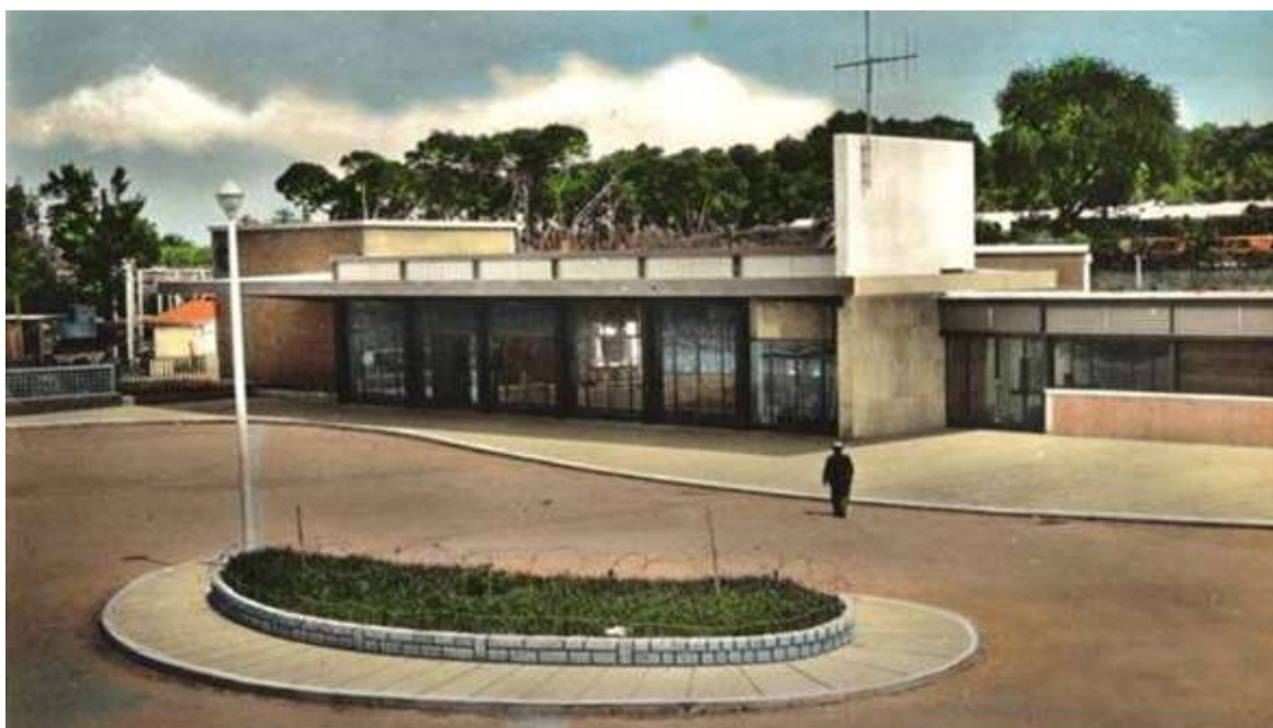
Figure 127 : Carte postale d'ensemble de la Gare de Chlef, Réalisation 1956 412
