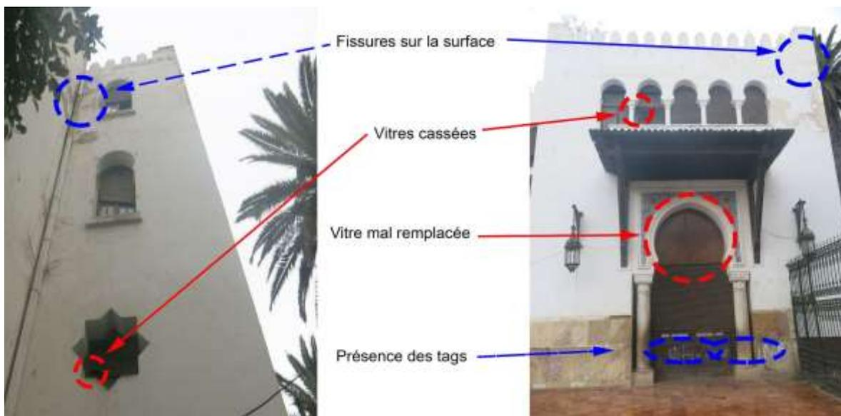
Figure 300 : État de quelques éléments d'architecture de la gare d'Oran, 2019 <sup>599</sup>
