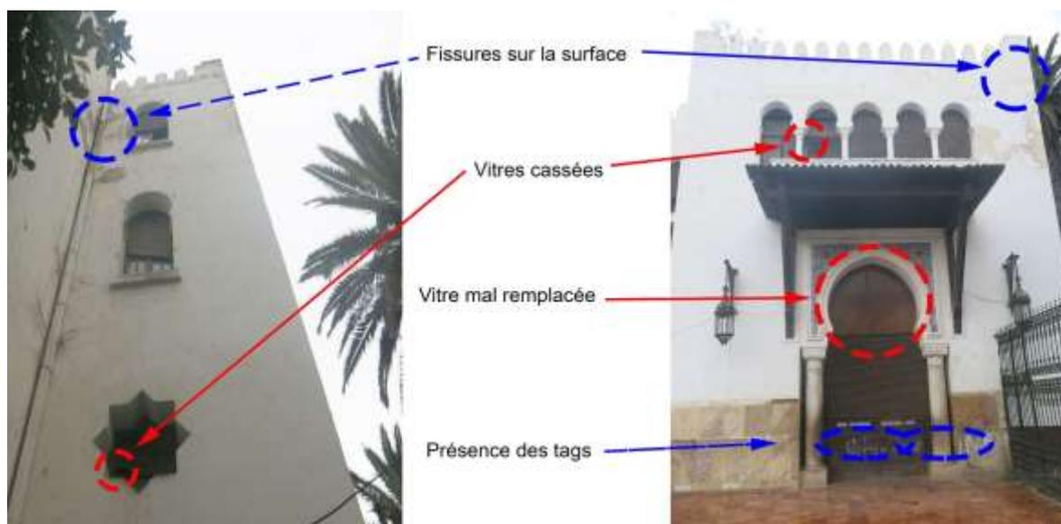
Figure 49 : État de quelques éléments d'architecture de la gare d'Oran, 2019<sup>53</sup>
