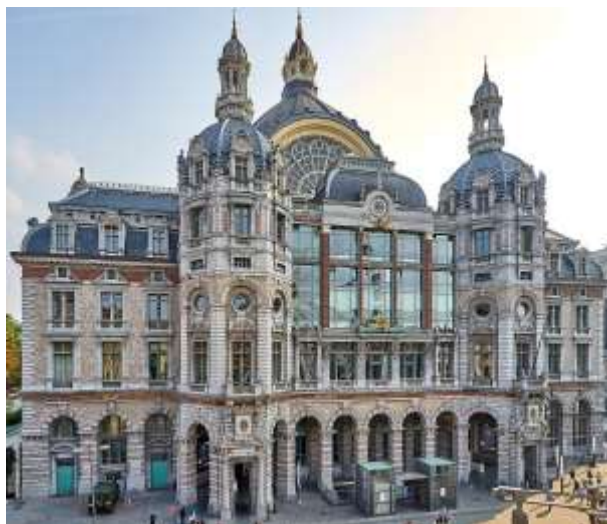
Figure 91 : La gare d'Anvers-Central en Belgique 359
