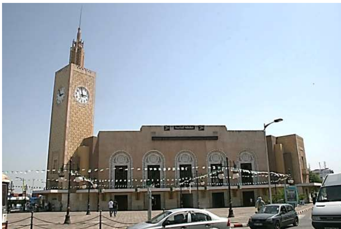
Figure 96 : Vue générale de la gare d'Annaba, avant rénovation, Compagnie de Bône-Guelma 371
