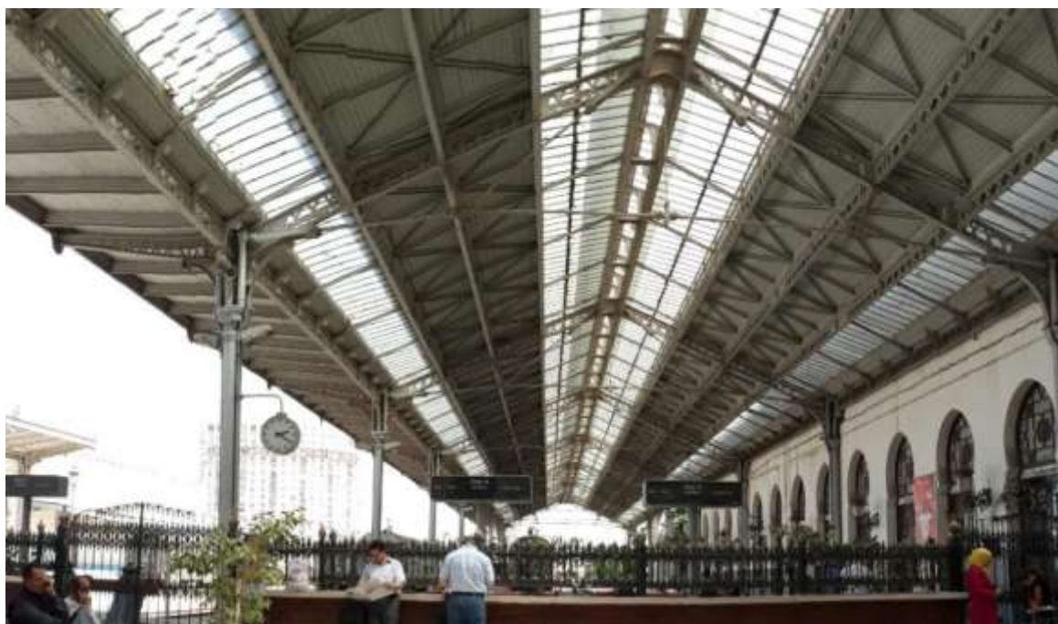
Figure 41 : Vue sous la halle de la gare d'Oran 43
