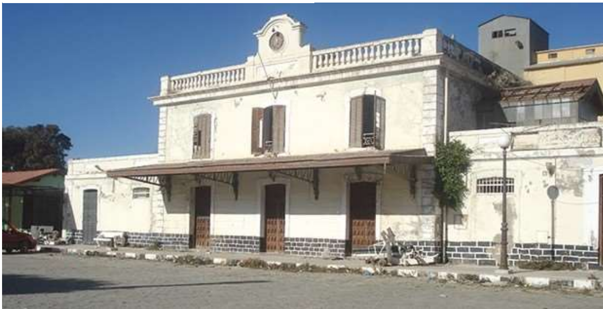
Figure 83 : Vue générale de l'ancienne gare ferroviaire de Aïn Témouchent — Réalisation de 1882, Compagnie de l'Ouest algérien 346
