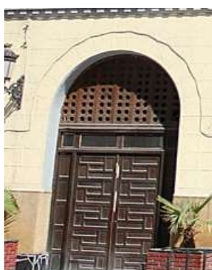
Figure 74 : Entrée de la gare d'Alger
