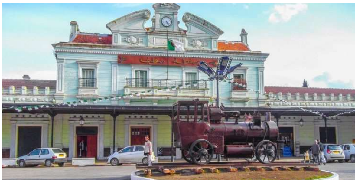
Figure 80 : Vue générale de la gare de Sétif — Réalisation de 1879, Compagnie de l'Est algérien 344
