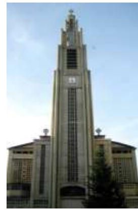
Figure 170 : Le campanile de l'église Notre-Dame de la Consolation au Raincy en France
