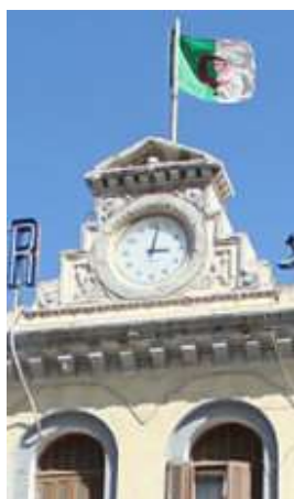
Figure 79 : Fronton de la gare d'Alger
