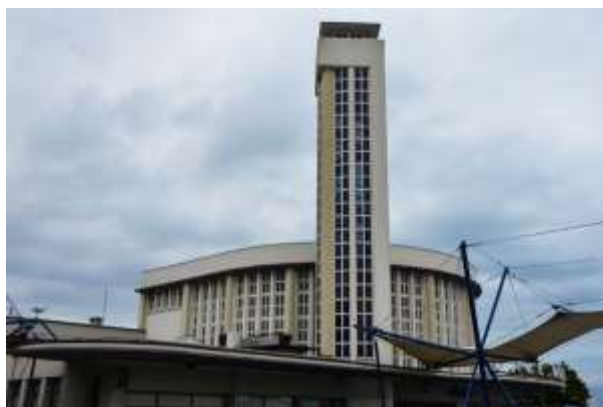
Figure 122 : Seconde vue générale de la gare de Brest, en France 403
