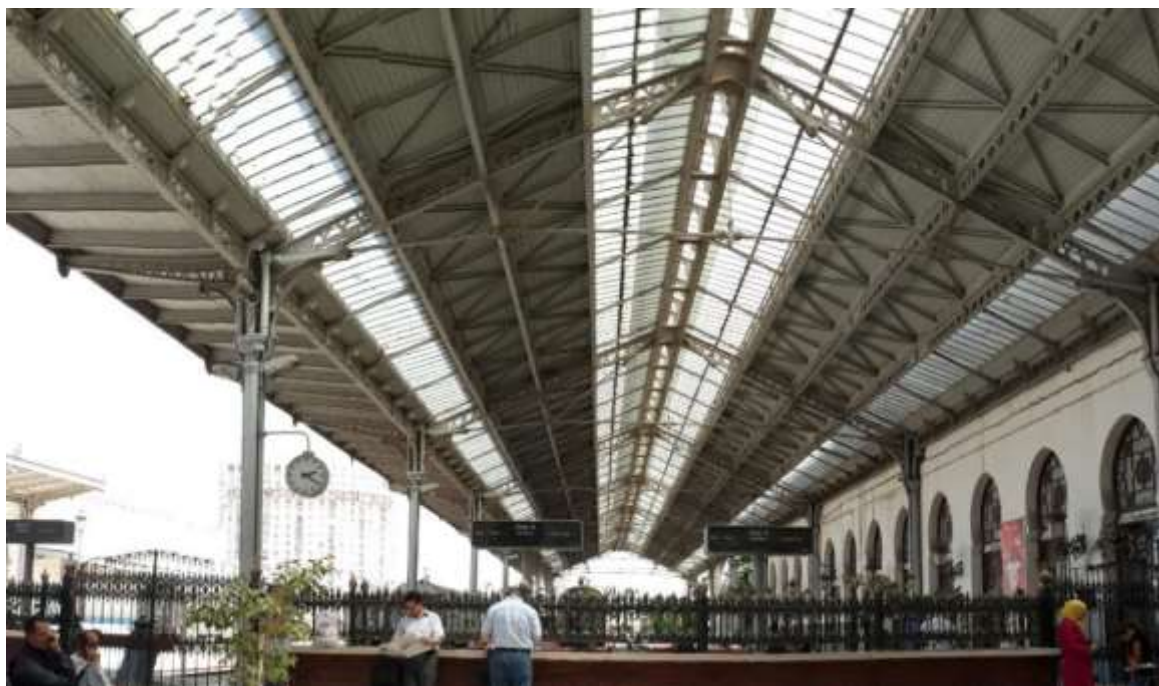
Figure 281 : Vue sous la halle de la gare d'Oran 572
