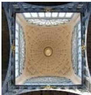
Figure 174 : La coupole de la gare d'Anvers vue de l'intérieur
