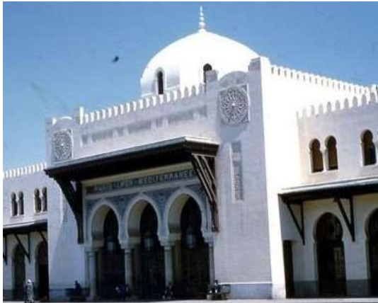
Figure 177 : Vue extérieure de la coupole de la gare d'Oran
