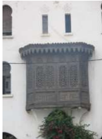
Figure 203 : Les loggias au niveau du buffet de la gare d'Oran
