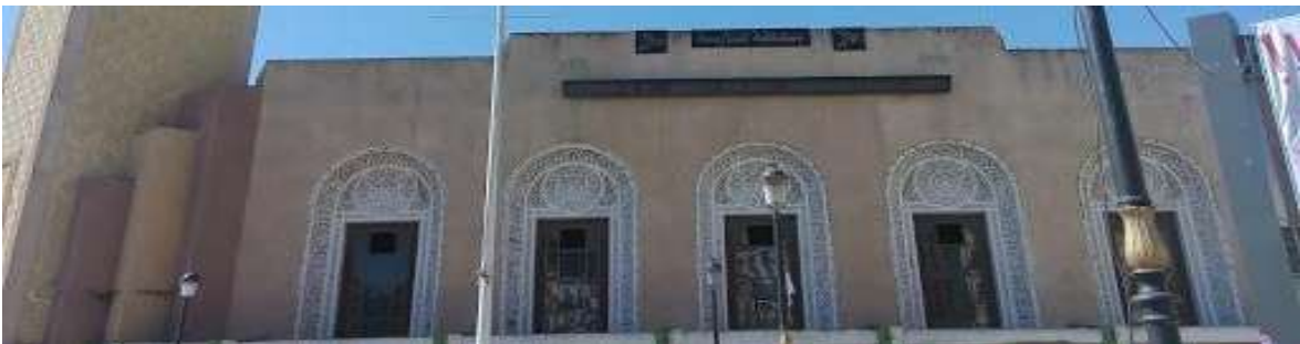
Figure 200 : Aperçu sur les ouvertures de la gare d'Annaba
