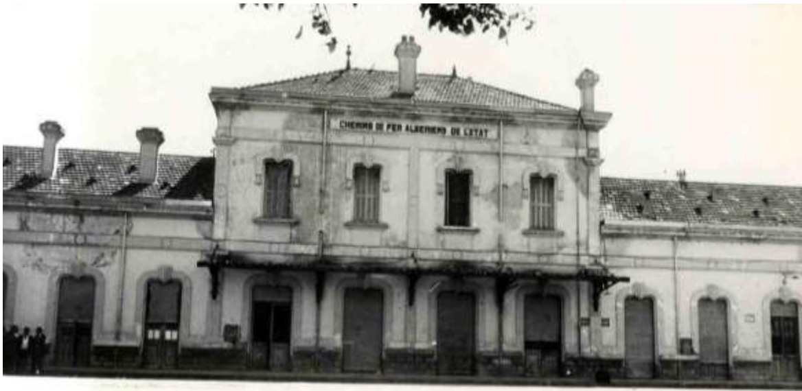
Figure 88 : Vue générale de la gare de Mohammadia « Mascara » — Réalisation de 1879, Compagnie PLM 352
