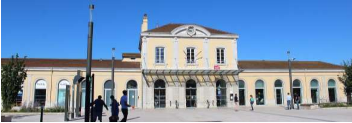
Figure 157 : Vue générale sur la gare de Bourg-en-Bresse en France, Compagnie PLM 450
