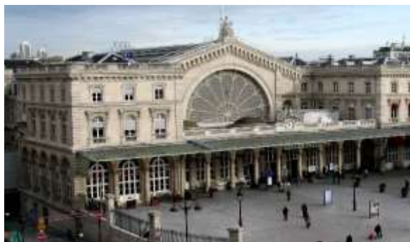
Figure 85 : La gare de l'Est à Paris, en France 349
