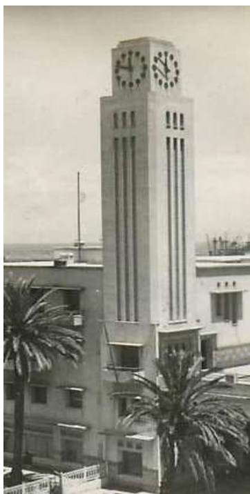
Figure 171 : La tour d'horloge de la gare de Skikda pendant la période coloniale
