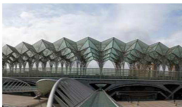
Figure 152 : Vue générale de la gare de Lisbonne-Oriente au Portugal 443
