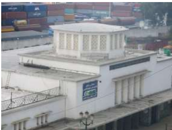
Figure 179 : Vue extérieure de la coupole de la gare de Skikda
