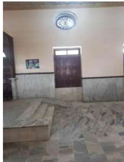
Figure 237 : Vue de l'intérieur de la gare d'Alger montrant l'utilisation du marbre pour le sol et les murs 521
