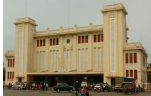
Figure 125 : Vue générale de la gare de Phnom Penh au Cambodge 409
