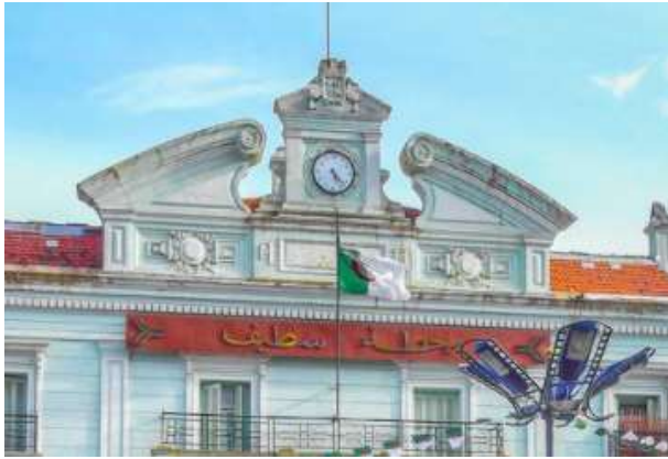
Figure 81 : Fronton entrecoupé de la gare de Sétif
