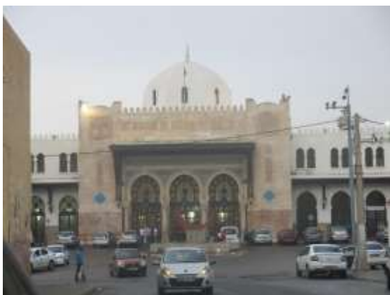
Figure 189 : L'auvent en bois de la gare d'Oran 465
