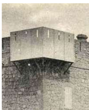
Figure 111 : Créneaux pour les tireurs sur une gare fortifiée
