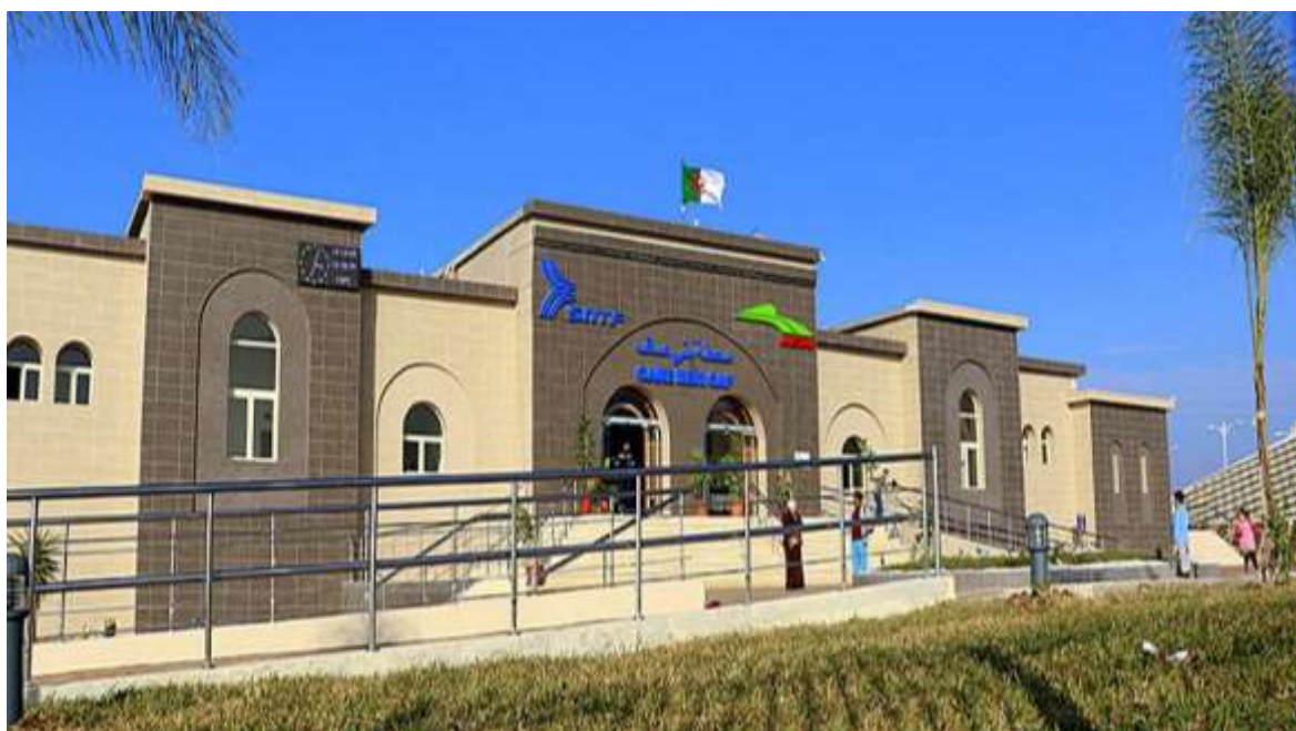
Figure 143 : Vue générale de la gare de Beni Saf— Réalisation de 2015 ANERSIF 433
