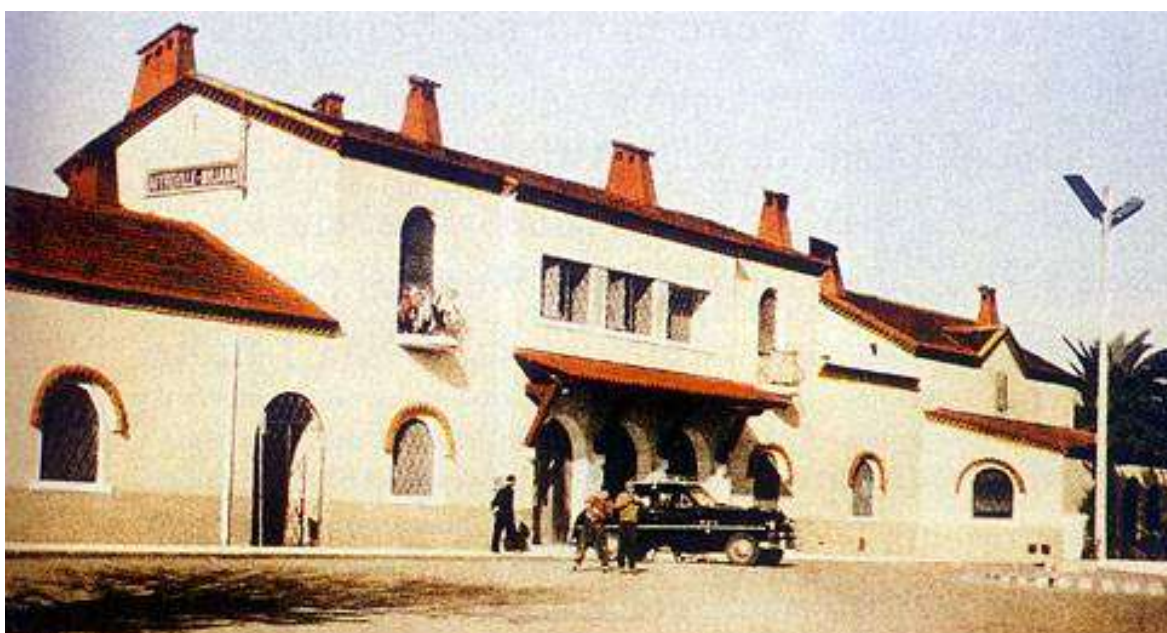
Figure 89 : Vue générale de la gare de Khemis Miliana, Compagnie — Réalisation de 1879, PLM 355
