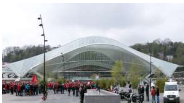
Figure 151 : Vue générale de la gare de Liège-Guillemins en Belgique 442
