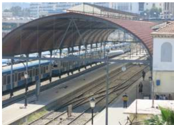
Figure 184 : La halle de la gare d'Alger 462
