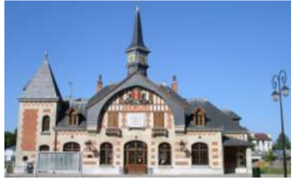
Figure 140 : Vue générale de la gare de Senlis en France 427
