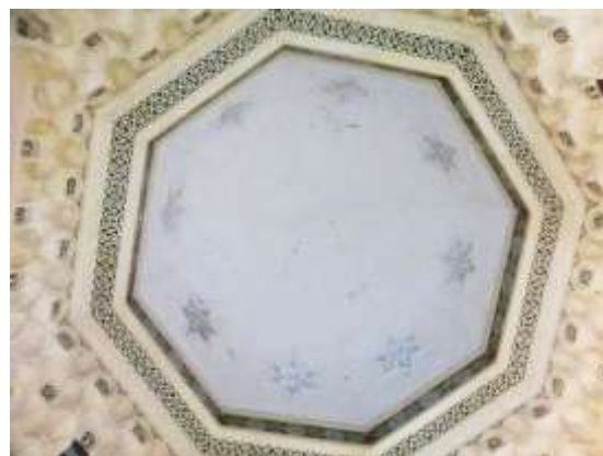
Figure 241 : Vue de dessous de la coupole centrale de la gare d'Oran 527 .
