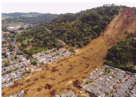
(c) Glissement de terrain survenant à la suite d'un séisme (Las Colinas, Santa Tecla, El Salvador)
