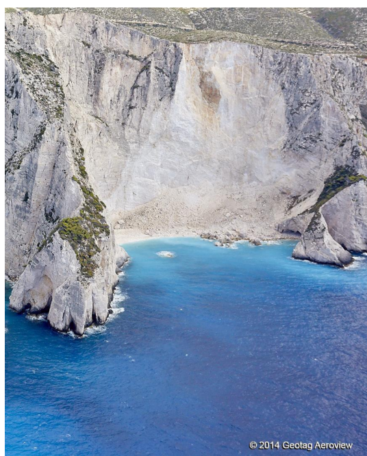
(a) Erosions des falaises de Zakyntos (Plage du naufrage, Grèce)
