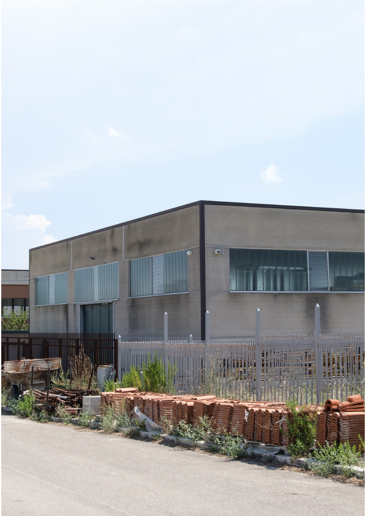
Img 16: Edifici della zona P.I.P. di Biccari, Febbraio 2019
