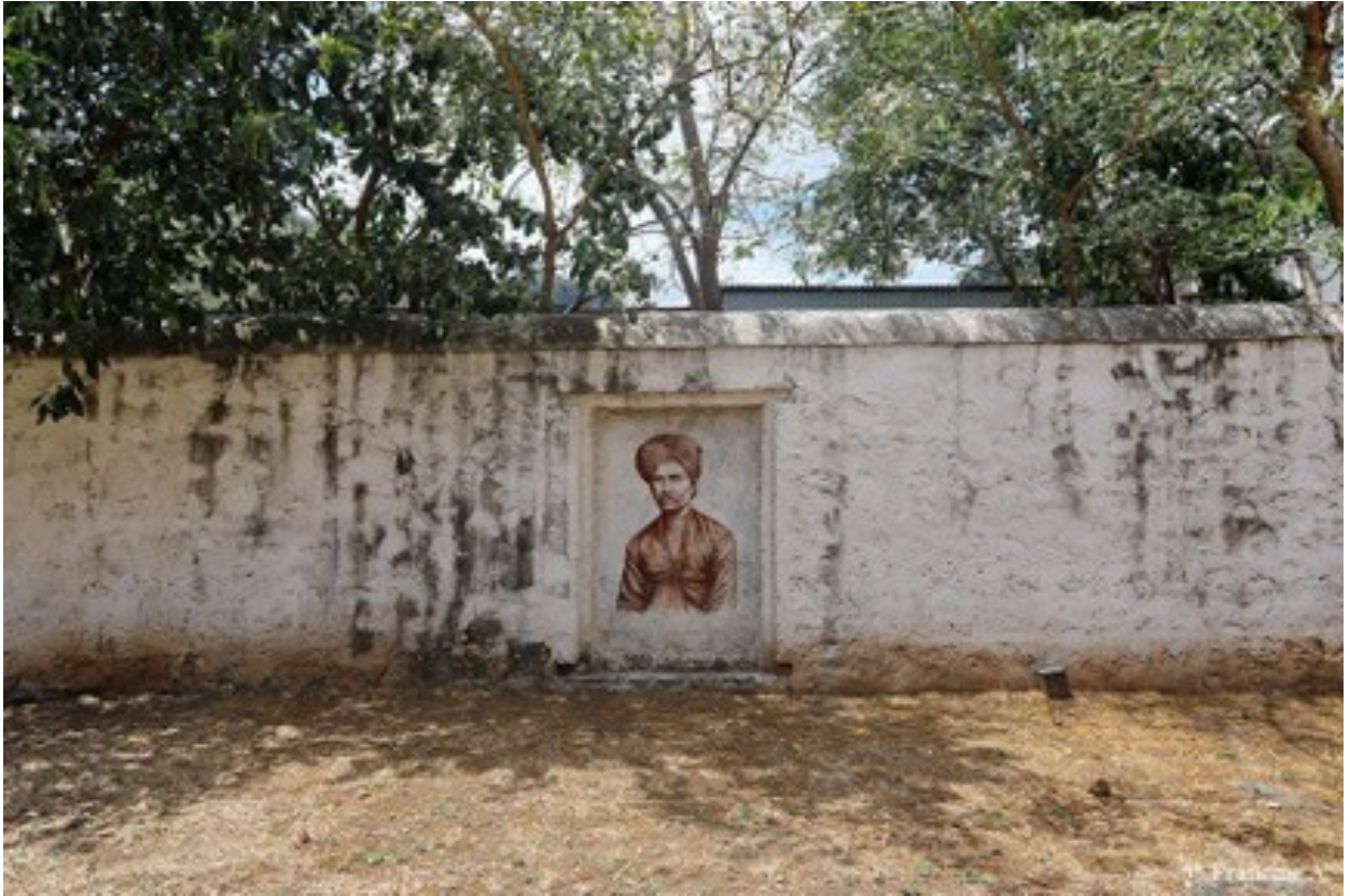
Figure 31- Photographie du Lazaret de la Grande Chaloupe : Pavillon d'isole- ment pour séparer les passagers en bonne santé des malades isolé par des murs épais.
