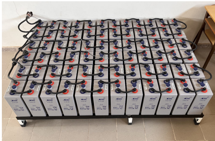
FIGURE 3.5 : Parc des nouvelles batteries installées sur le site de la centrale [KG23a].
