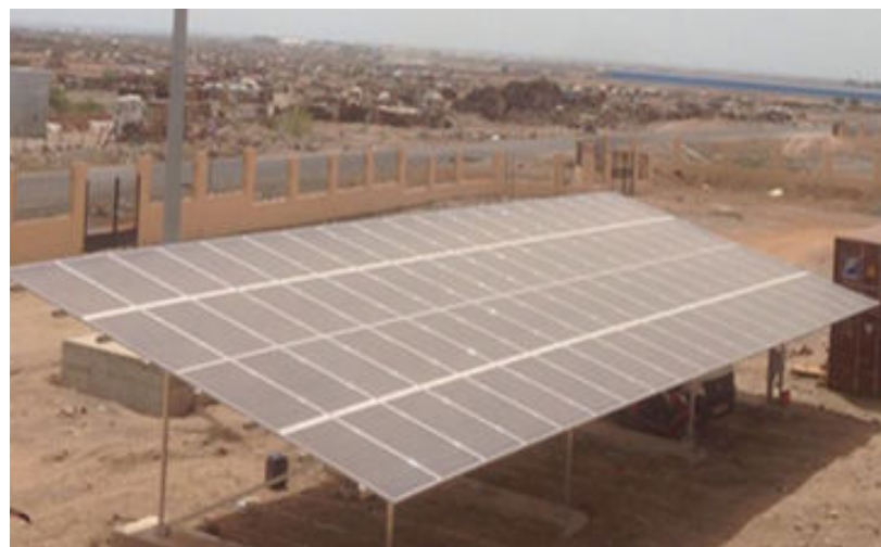
FIGURE 3.2 : La vue présente l'installation photovoltaïque qui a été mise en place à l'université. On peut identifier les quatre rangées comprenant chacune 19 panneaux solaires individuels de 250 Wc. Les dimensions globales de l'installation sont de 6,7 m de large x 19 m de longueur. Les panneaux sont installés à une hauteur de 2 mètres par rapport au point le plus bas du sol.
