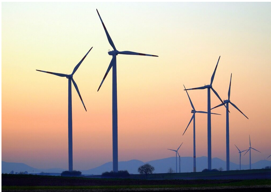
FIGURE 1.1 : Parc éolien installé à Ghoubet (Crédit photo : [PAU23]).
