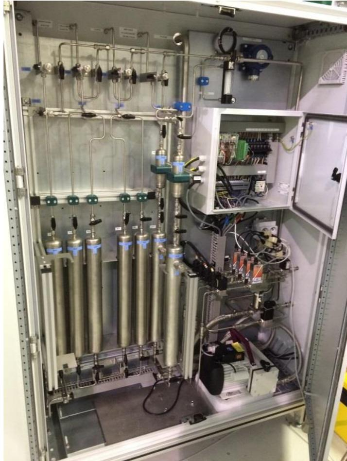
Figure 47. Système de régulation du mélange gazeux, modifié avec l'ajout de filtres supplémentaires et de nouvelles connectiques. Ces modifications permettront de limiter l'apparition d'impuretés dans le mélange gazeux.
