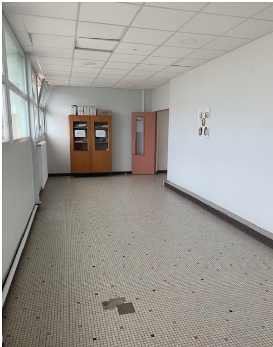
Figure 33 : Photos des couloirs et dégagements de J
