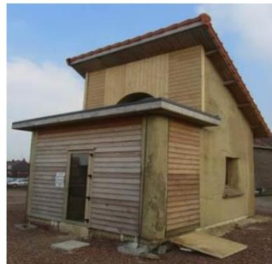
Figure I. 20 : Bâtiment test construit en briques de terre crue [El Fgaier, 2013]
