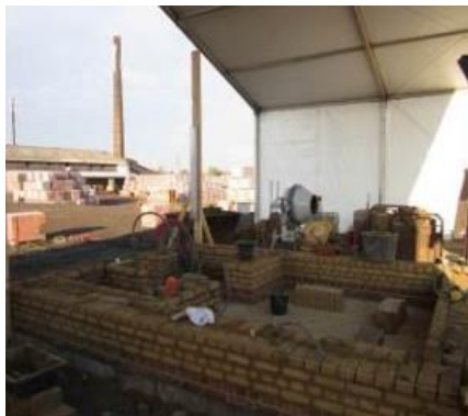
Figure I. 20 : Bâtiment test construit en briques de terre crue [El Fgaier, 2013]
