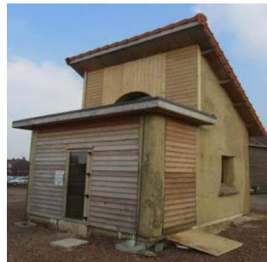
Figure I. 20 : Bâtiment test construit en briques de terre crue [El Fgaier, 2013]
