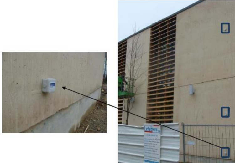
Figure I. 21 : Bâtiment R+1 prototype en béton de terre « Cématerra » [Hibouche, 2013]
