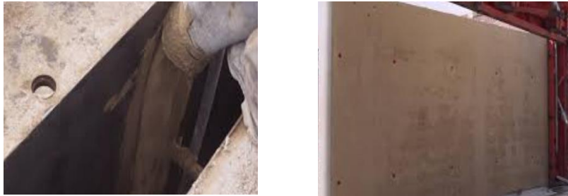
Figure I. 5: Mur en terre coulée
