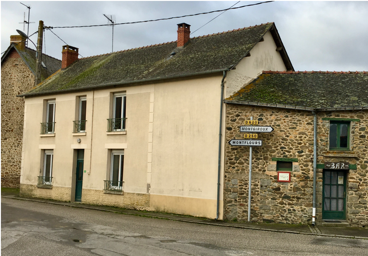
Maison jouxtant le bar associatif où la municipalité de Sacé a relocalisé le Point Lecture et projette un nouveau lieu destiné à des usages pluriels et collectifs.
