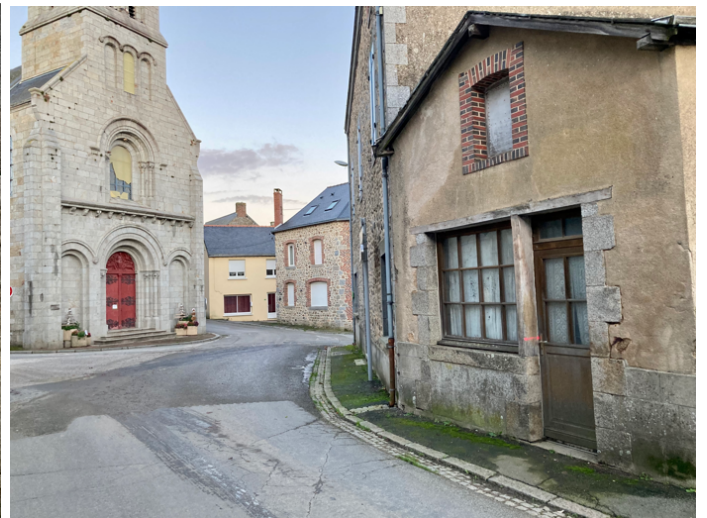
Ancien commerce localisé dans le centre du bourg transformé pour un usage résidentiel mais inoccupé.
