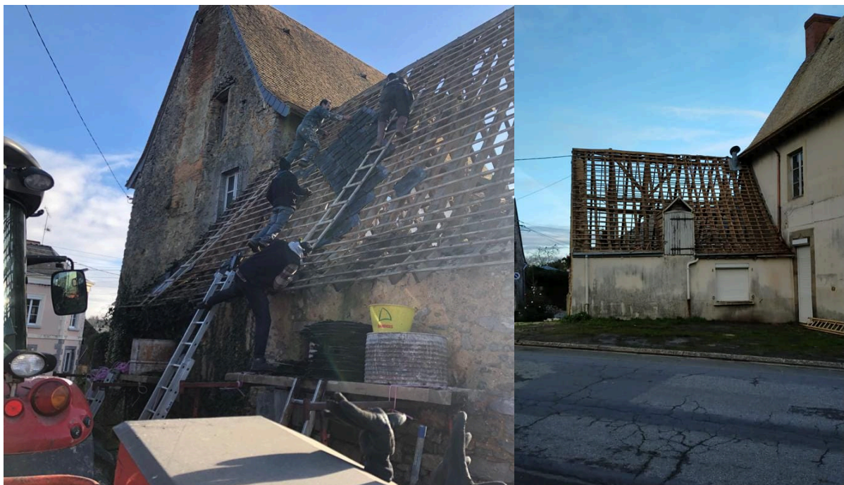
Photographies du chantier participatif de déconstruction de la maison annexe à la future Maison Commune à La Bazouge de Cheméré (source : transmises par enquêtés)
