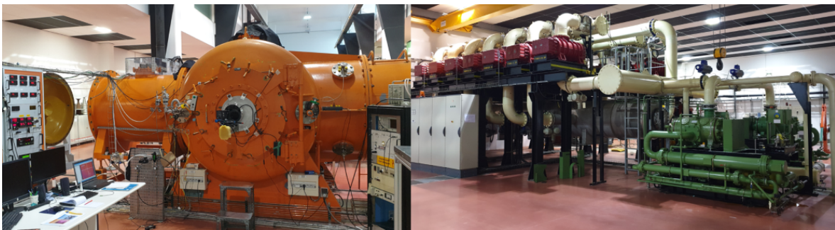
FIGURE 4.4 – Photographie de MARHy et du groupe de pompage.
