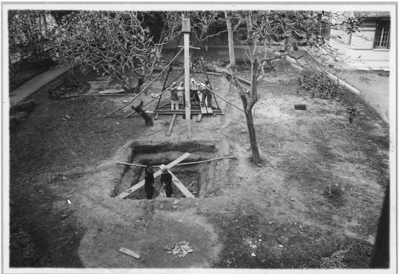
Figure 29: EFEO, construction de la nouvelle bibliothèque, état des travaux, enfoncement d'une pièce en béton armé, s. d. (légende de la photothèque de l'EFEO) – Photothèque de l'EFEO VIE23174
