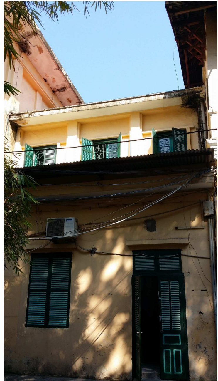
Figure 27: Passerelle reliant la « nouvelle bibliothèque » de l'EFEO au bâtiment principal abritant la salle de lecture, novembre 2016 – Photographie Cécile Capot
