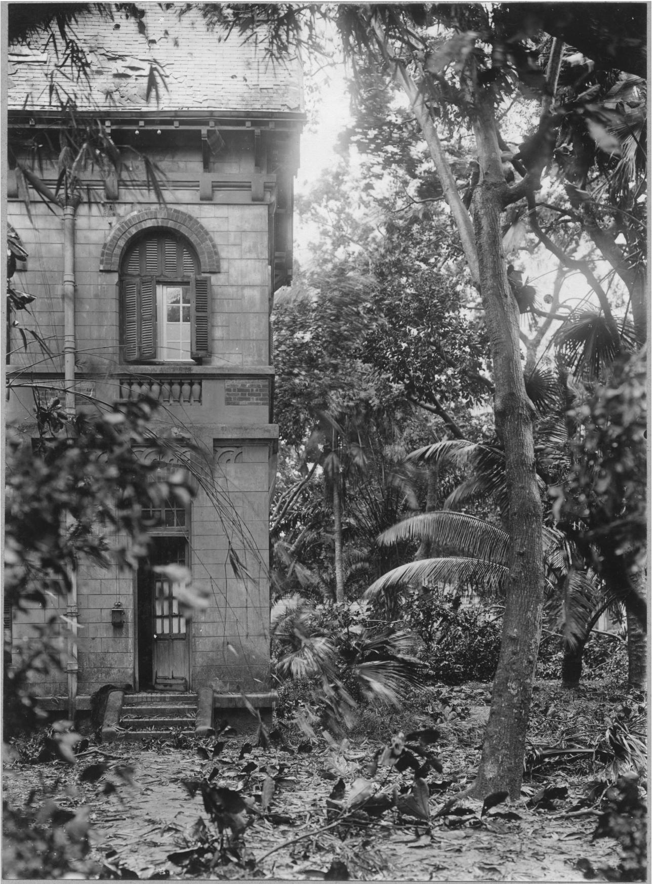
Illustration 16: EFEO, bibliothèque du logement du directeur après le typhon, (vue de l'angle nord-ouest), s. d. (légende de la photothèque de l'EFEO) – Photothèque de l'EFEO VIE23229
