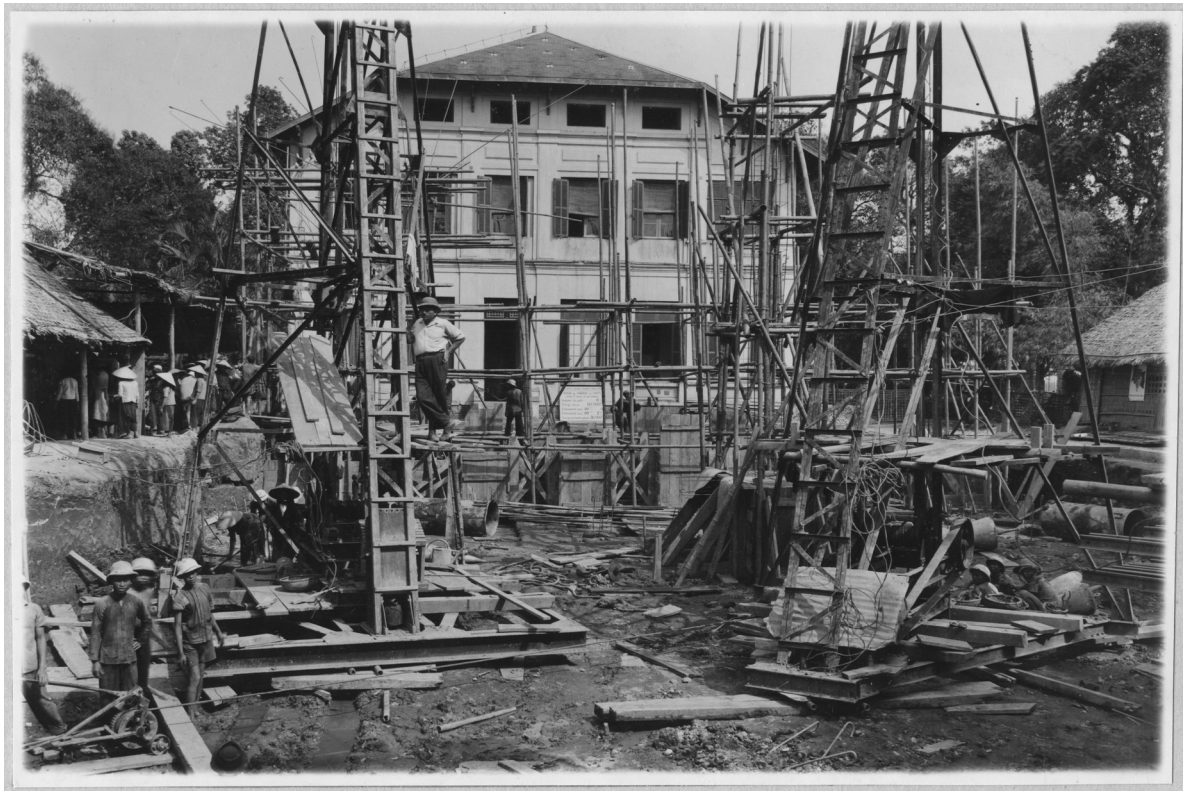
Figure 31: EFEO, construction de la nouvelle bibliothèque, état des travaux, (vue extérieure) (légende de la photothèque de l'EFEO) – Photothèque de l'EFEO VIE23179
