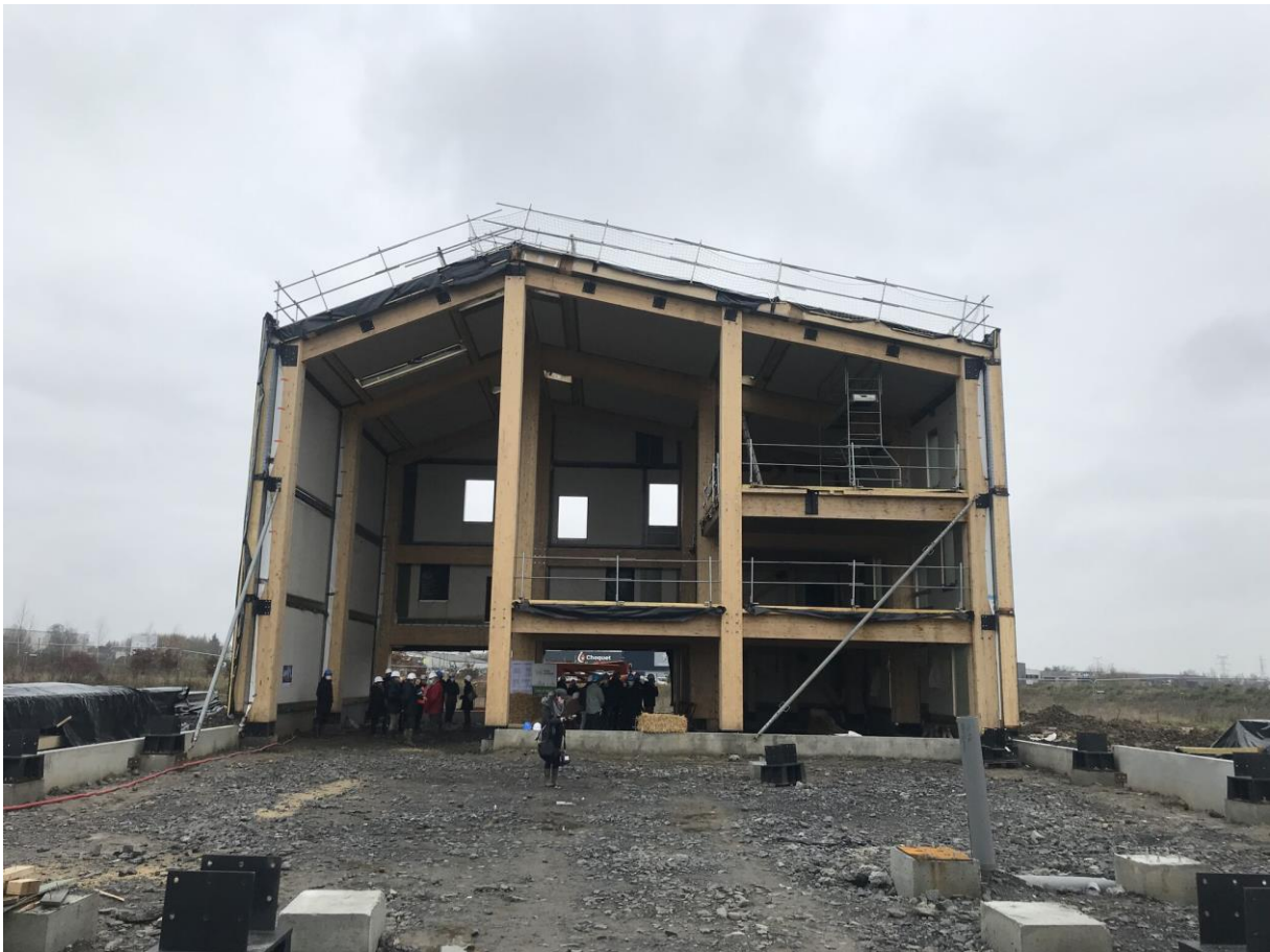
Figure 41 : Chantier de la Passerelle. Source : Pévèle-Carembault, 2021.
