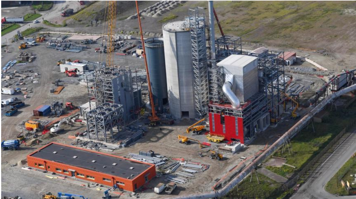
Figure 44 : Site Ecocem, valorisation de laitier issu de l'usine sidérurgique ArcelorMittal. Source : La Voix du Nord, 2018.
