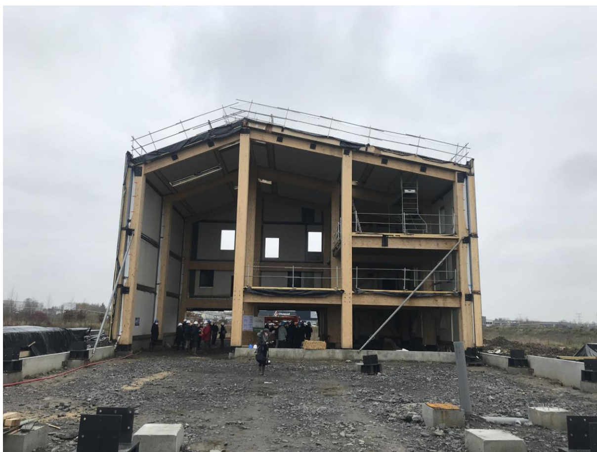
Figure 41 : Chantier de la Passerelle. Source : Pévèle-Carembault, 2021.
