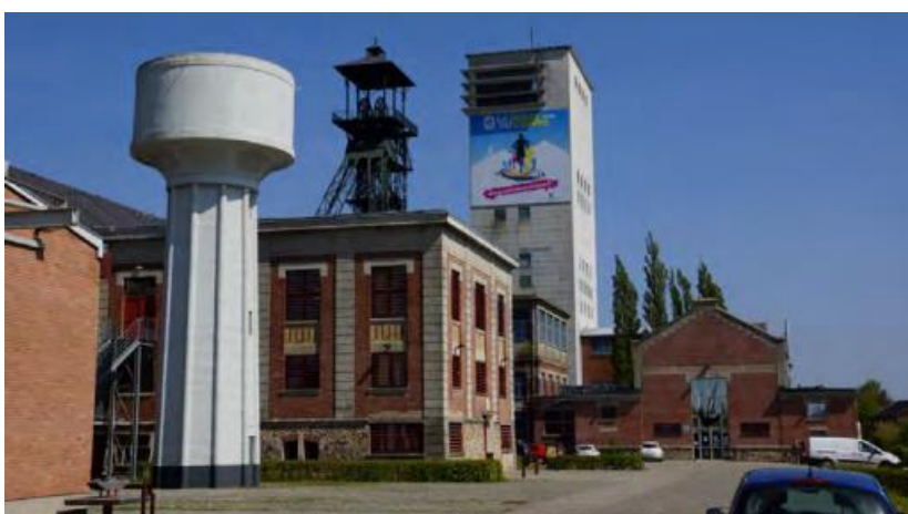
Figure 35 : Carreau de fosse (et chevalement) de la base 11/19 à Loos-en-Gohelle. Source : Mission Bassin Minier, 2015.
