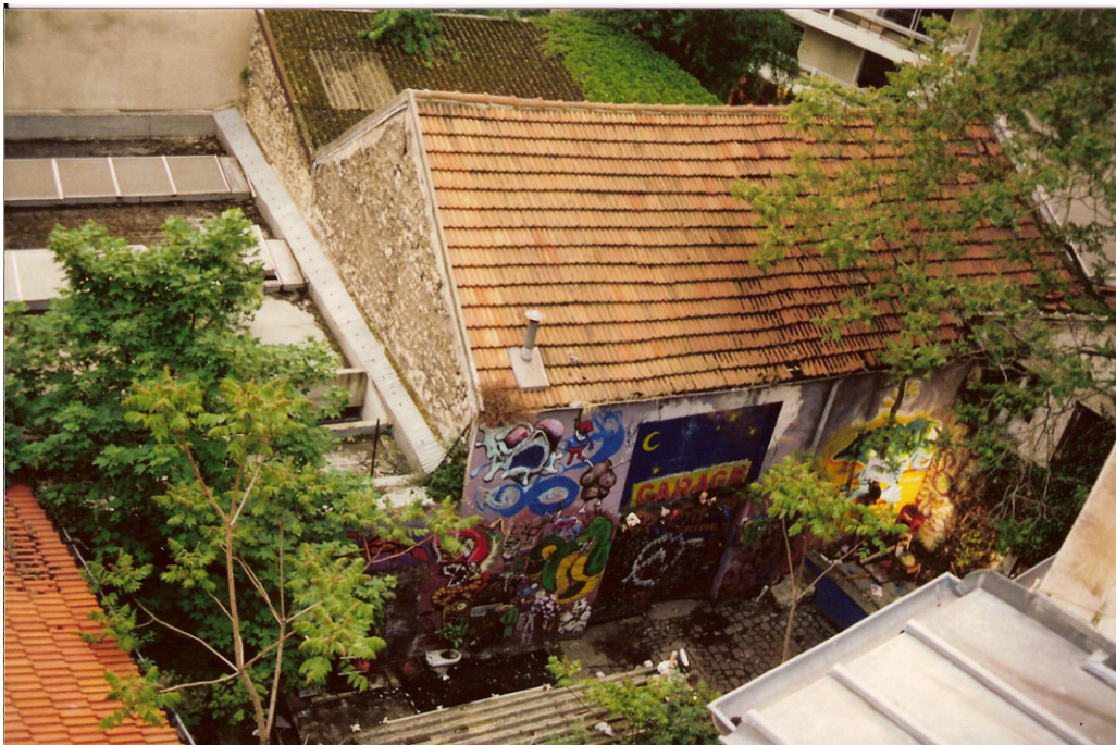
La cour restaurée, vue depuis le toit du 78 puis (ci-dessous) sous la guérite
