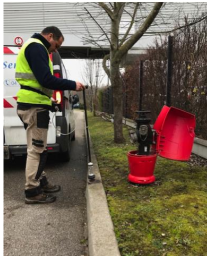
Figure 1.17. Principe de détection par l'enregistreur de bruit sans fil [155]
