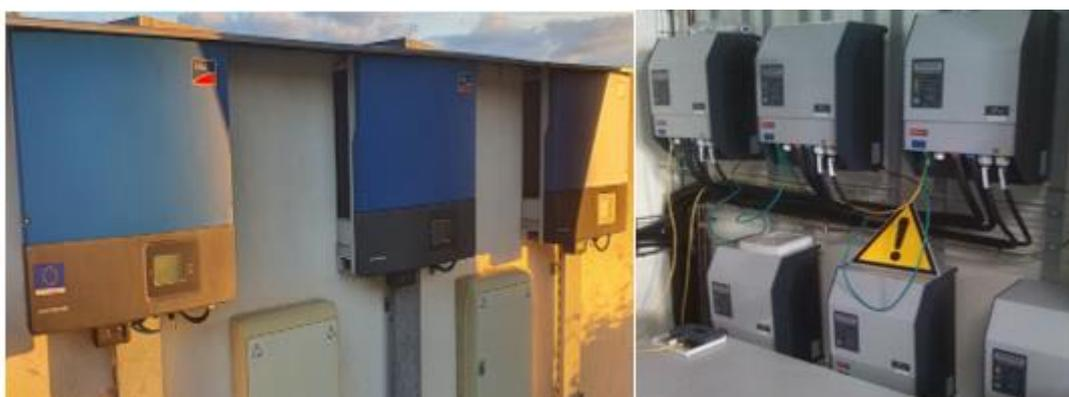
Figure 2-9 : Onduleur PV réseau et onduleur chargeur
