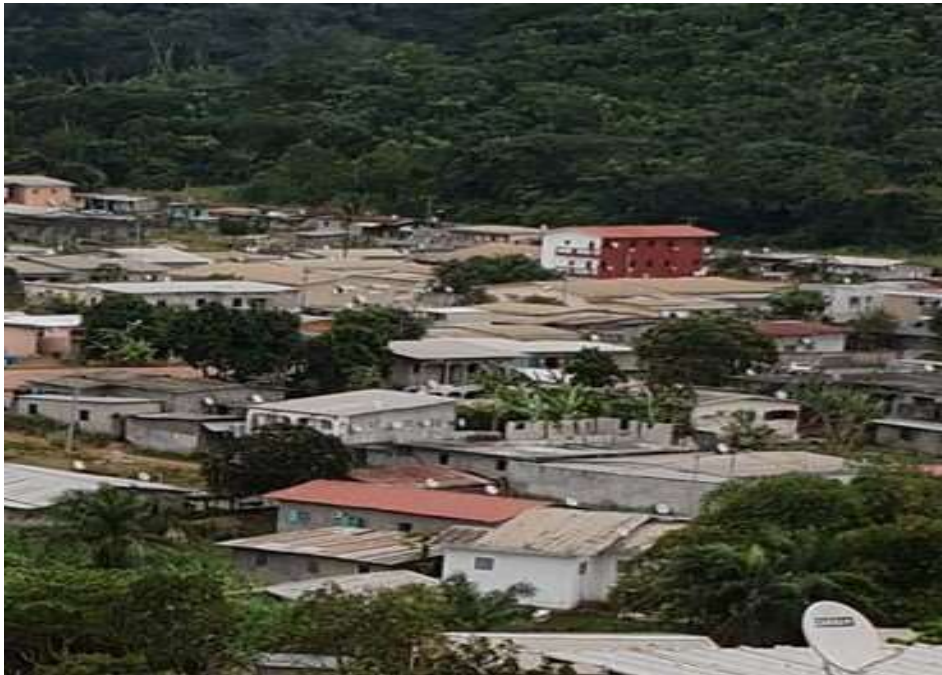
Figure 6 : Antennes paraboliques du groupe Canal+ à Charbonnages (Libreville).
