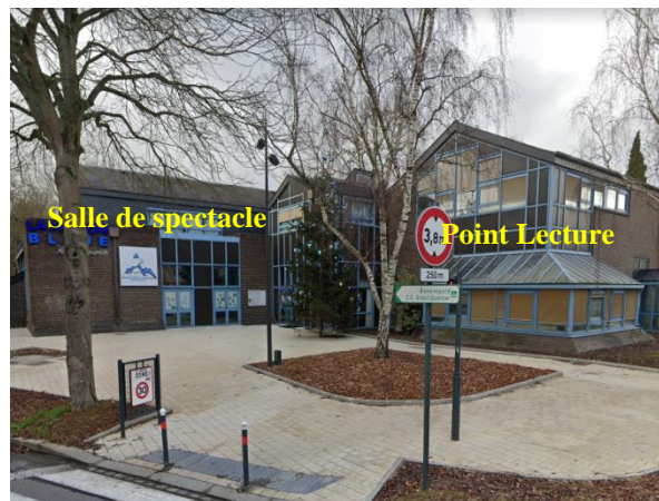
Figure 74. Maison de Quartier La Maison Bleue : Salle de spectacle et Point Lecture
