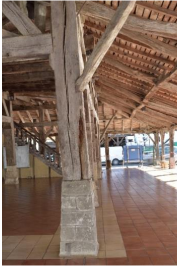
a) le poteau au coin sud-ouest du deuxième portique déverse vers le nord-ouest b) assemblage poteau poutre au coin nord-ouest du deuxième portique
