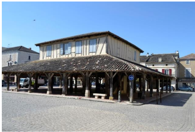
Figure 2.1- Vue d'ensemble de la halle de Villeréal
