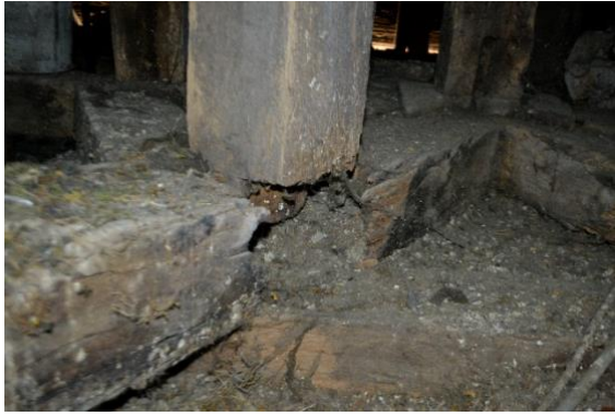
a) Altération par les champignons d'un pied de poteau dans les combles
