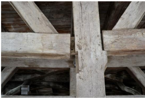
a) Altération par les champignons d'un pied de poteau dans les combles
