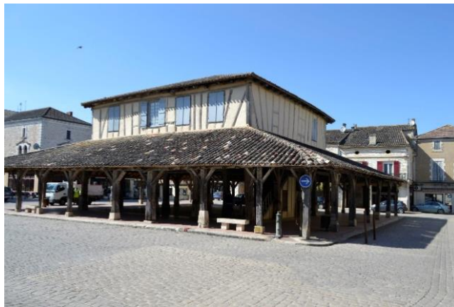
Figure 2.1- Vue d'ensemble de la halle de Villeréal
