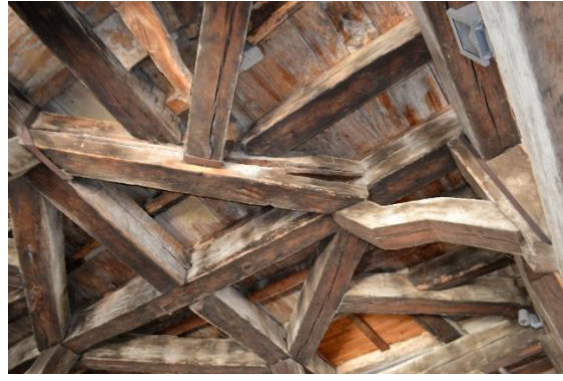
b) Fente d'une poutre de l'enrayure sur les poteaux centraux
