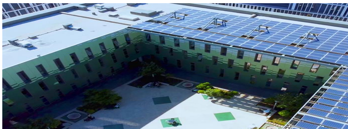
Figure 113. Eco-campus de l'UEMF présentant des panneaux photovoltaïques sur les toits et les façades
