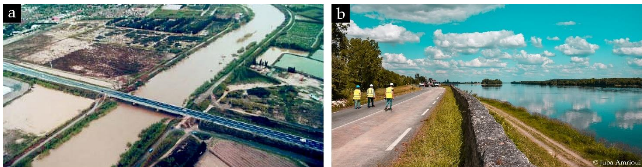
Fig. 2. (a) Vue aérienne du cours aval endigué du fleuve côtier Agly, juste après la crue des 12-13/11/1999 (© F. Hédelin – Pyrénées Orientales) ; (b) Une levée de la Loire Moyenne : digue en remblai avec une voie de circulation en crête (© J. Amrioui – site LA).
