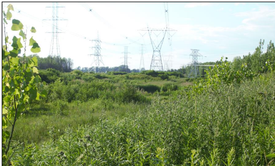
Figure 170 : Percée paysagère le long d'une ligne à haute tension.
