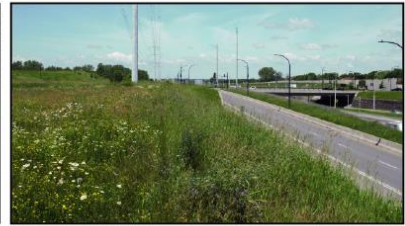
L'A25 près du Ruisseau de Montigny
