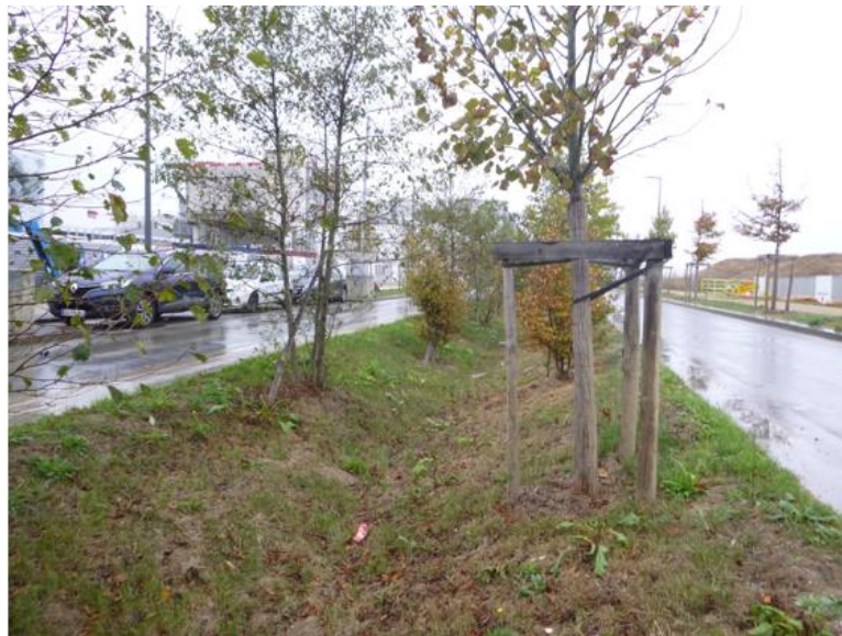
Figure 12 - Exemple de noue d'infiltration en terre-plein central (Orsay) : le long de la noue central, la bordure séparant la zone plantée du revêtement de chaussée est arasée : elle ne fait pas obstacle à une dispersion active de surface
