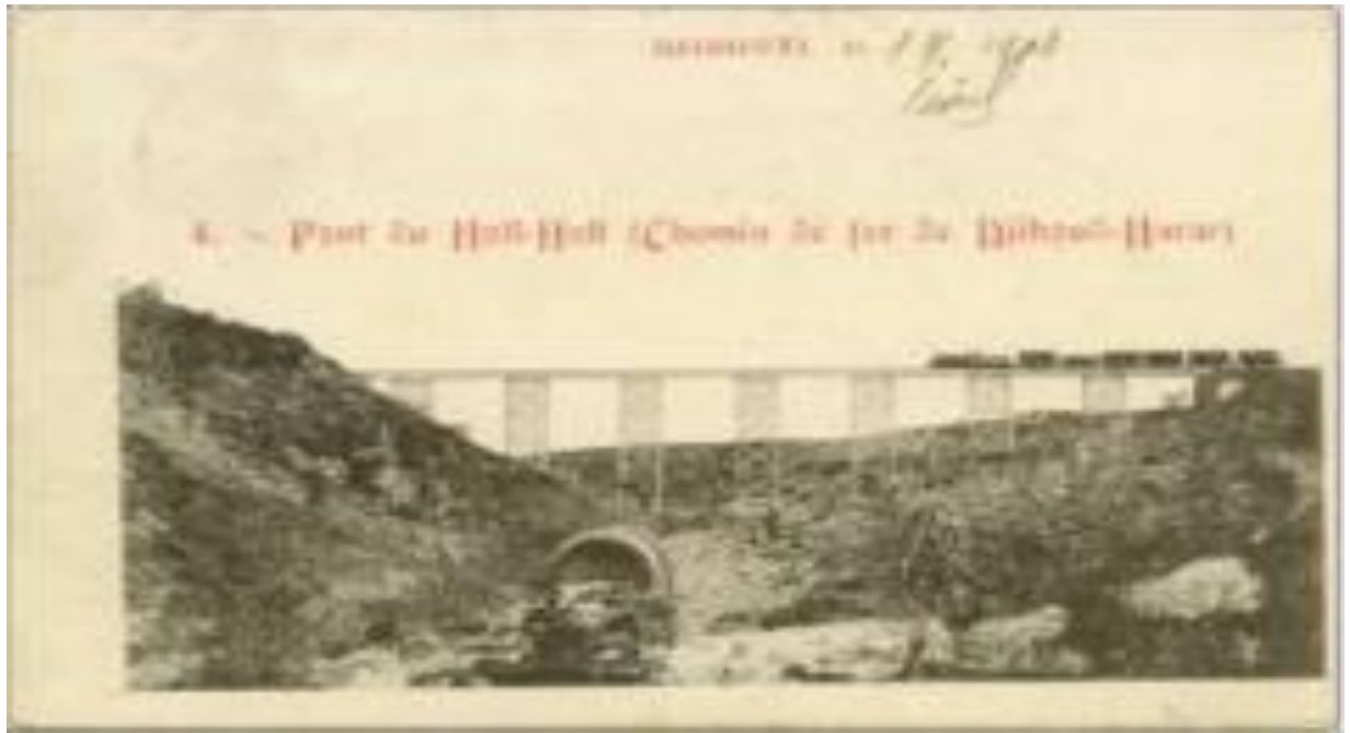
Figure I-6 : Pont de Holl-Holl 14
