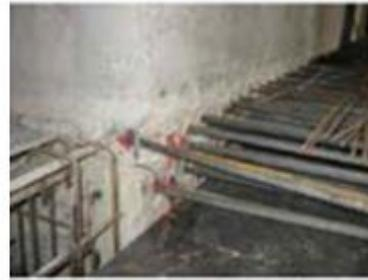
(b) Connexion mur-plancher
