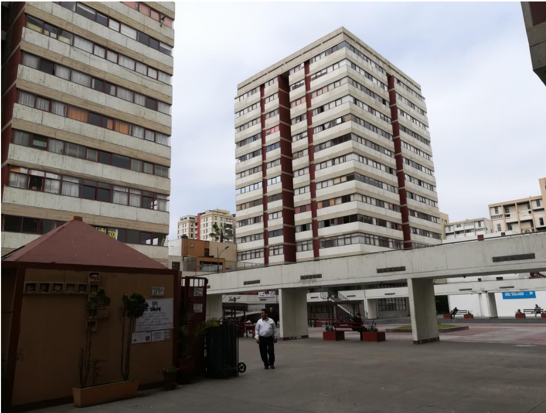
Henri Ciriani, Junta Nacional de la Vivienda, première tranche des travaux, détail des tours photographie, 1962-1963.
