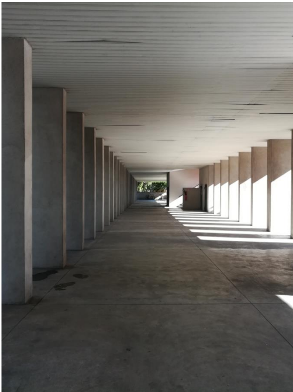
Aldo Rossi, portiques internes sur cour, photographie, 1967-1974. Cliché Alice Agostini, avril 2020.
