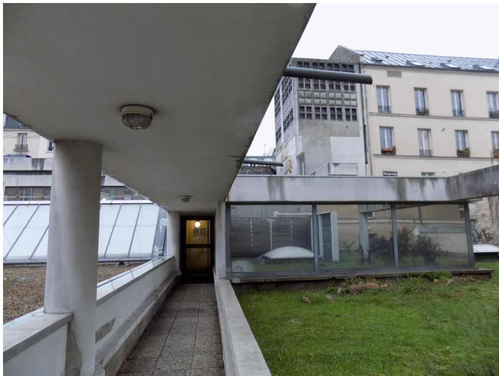
Toit-terrace, photographie, 1981-1985. Cliché Alice Agostini, janvier 2018.
