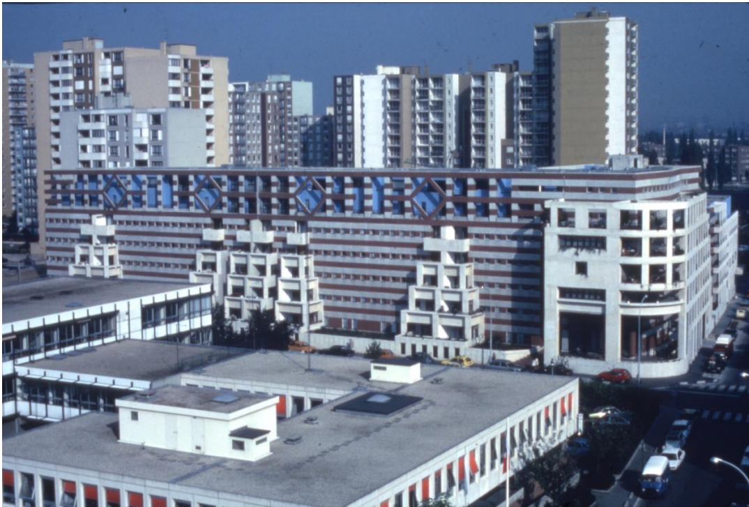
Figure 270 : La Cour d'angle, Saint-Denis
