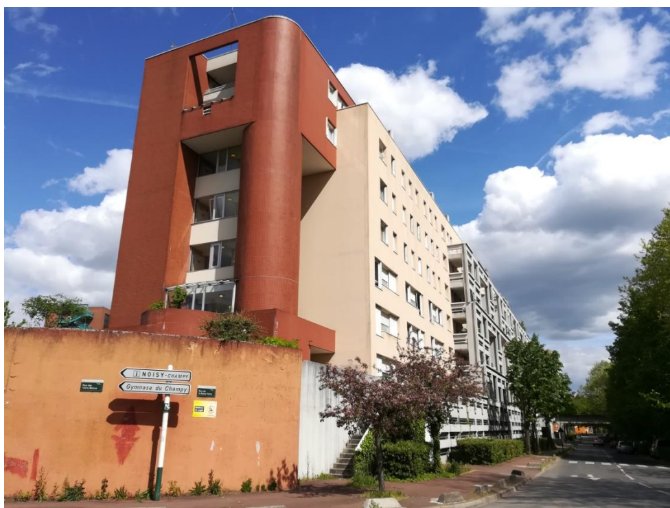
Façade avec loggias, photographie, 1978-1981. Cliché Alice Agostini, juillet 2018.
