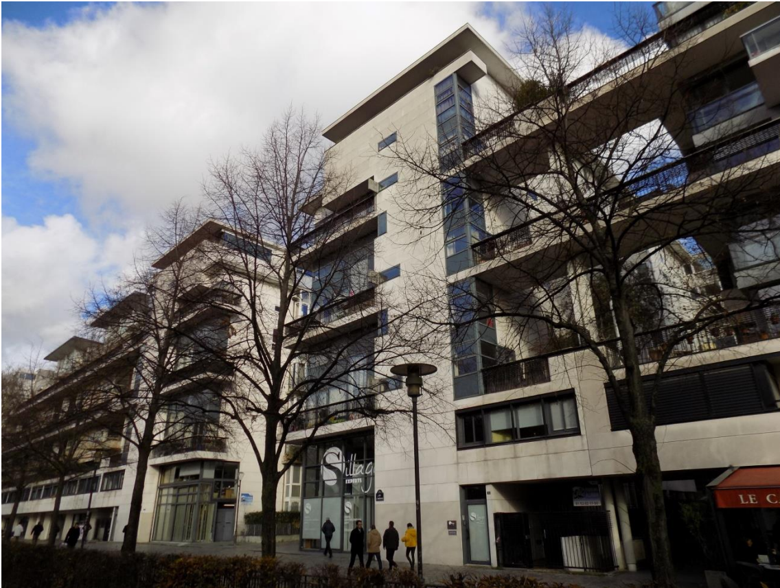
Figure 219 : immeuble de logements collectifs à Bercy, Paris
