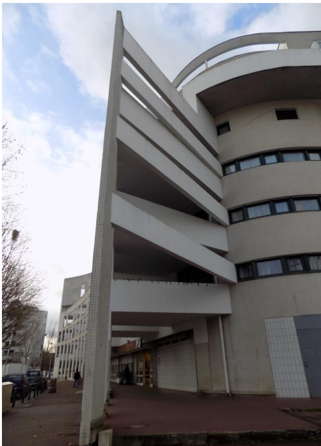
Façade, vue latérale, photographie, 1983-1986.
