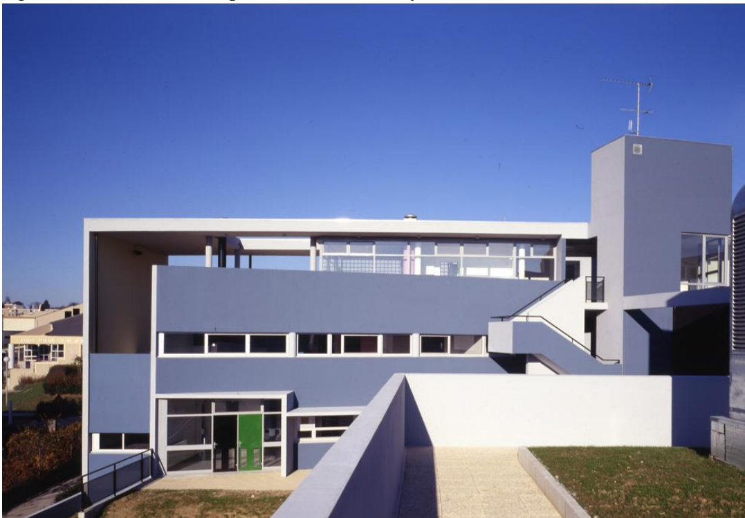
Façade nord sur cour, photographie, 1986-1989.
