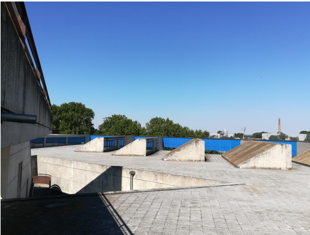
Vue depuis le toit-terrasse sur les sheds , photographie, 1983-1995. Cliché Alice Agostini, juin 2016.
