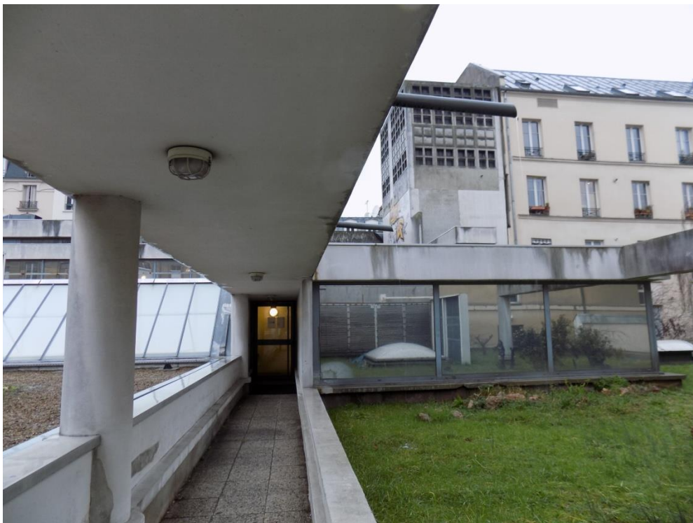
Toit-terrasse, photographie, 1981-1985. Cliché Alice Agostini, janvier 2018.
