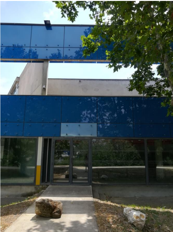
Façade sur le Rhone, plaque en métal en remplacement d'une plaque d'émailit, photographie, Arles, 1983-1995. Cliché Alice Agostini, juin 2016.
