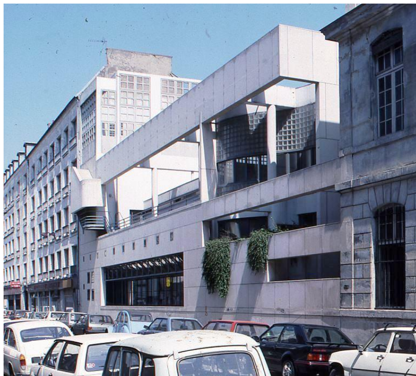
Figure 196 : cuisine de l'hôpital Saint-Antoine, Paris
