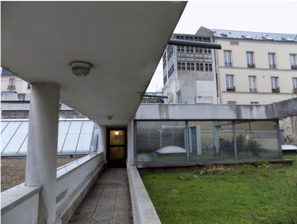
Toit-terrasse, photographie, 1981-1985. Cliché Alice Agostini, janvier 2018.
