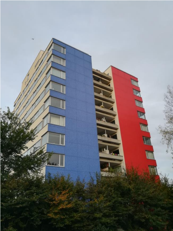
Façade, photographie, 1989-1995. Cliché Alice Agostini, novembre 2019.
