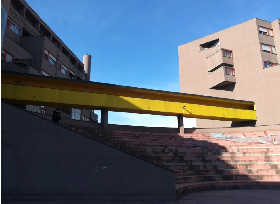
Carlo Aymonino, vue de l'une des passerelles de connexion des immeubles, photographie, 1967-1974. Cliché Alice Agostini, avril 2020.
