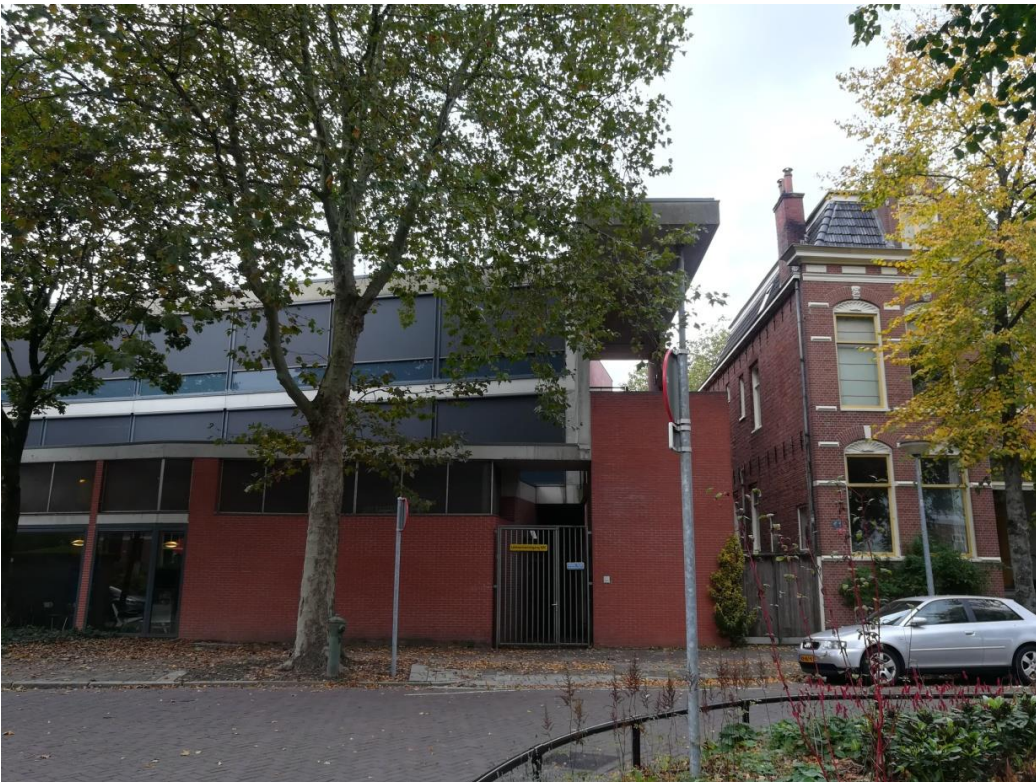
Vue de la façade sur rue, photographie, 1996-2001. Cliché Alice Agostini, juin 2019.
