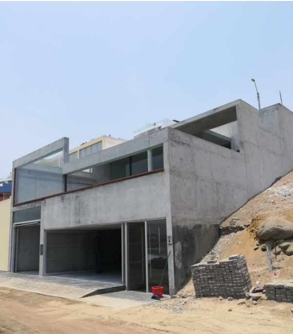
Façade principale, photographie, 2011-2013. Cliché Alice Agostini, octobre 2018.
