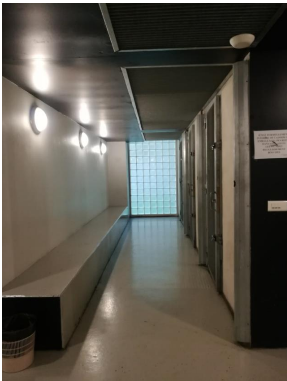
Couloirs souterrains, entre les cellules et les salles d'audience, photographie, 1997-2005. Cliché Alice Agostini, juillet 2020.
