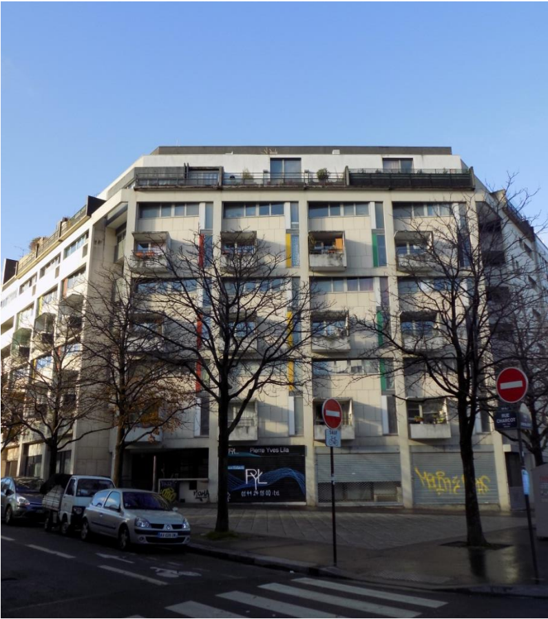
Façade d'entrée, photographie, 1987-1991. Cliché Alice Agostini, janvier 2018.
