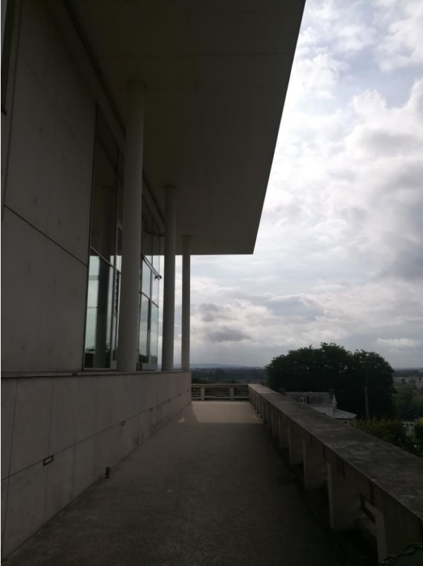
Terrasse sud-ouest, photographie, 1997-2005. Cliché Alice Agostini, juillet 2020.
