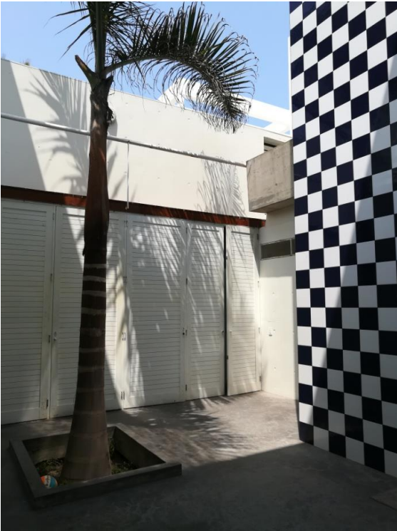
Vue de l'escalier dans le patio, photographie, 1998-1999. Cliché Alice Agostini, septembre 2018.
