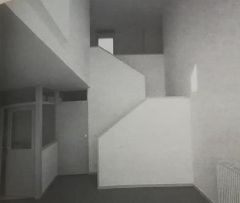
Figure 217 : immeuble entre la rue Charcot et la rue Chevaleret, Paris
