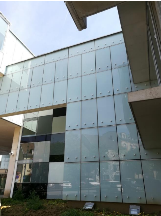
Façade est, détail des plaques d'émailit sur la baie vitrée, photographie, 1997-2005. Cliché Alice Agostini, juillet 2020.
