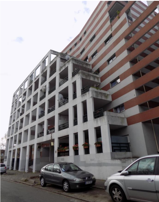
Façade sur rue Jean Mermoz, photographie, 1978-1982. Cliché Alice Agostini, septembre 2018.
