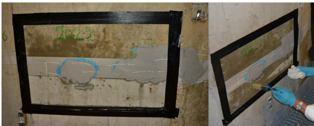
Figure VII.11 : Badigeonnage de la zone fuyarde TAM 2029.
