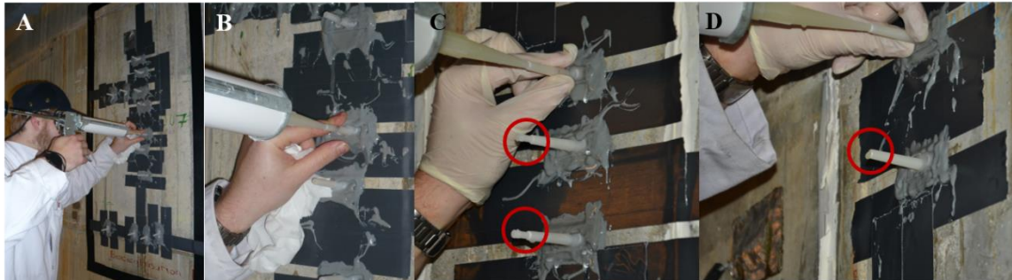
A et B : injection. C : bouchon pour éviter la sortie du fluide. D : sortie du fluide lors de l'injection d'une autre tête d'injection.
