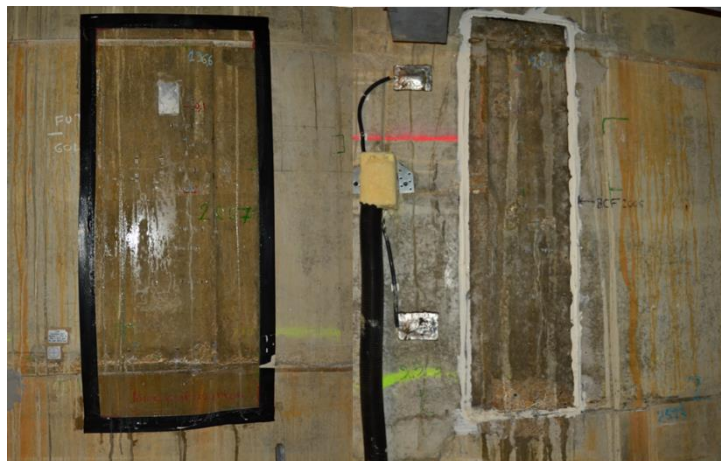
Figure VII.9 : Badigeonnage final des fissures verticales.
