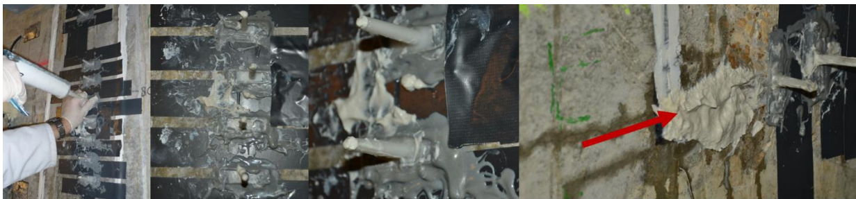
La flèche rouge indique le milieu épais injecté au niveau de la reprise de bétonnage.
