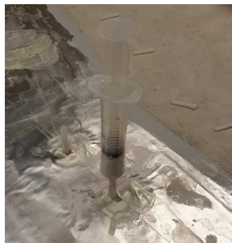
Figure VI.13 : Injection d'une fissure de la dalle.
