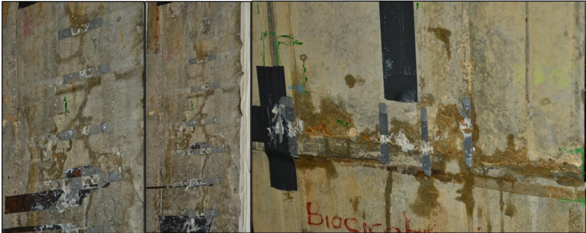
Figure VII.8 : Zones d'hydratation visibles lors de l'enlèvement du système d'injection.
