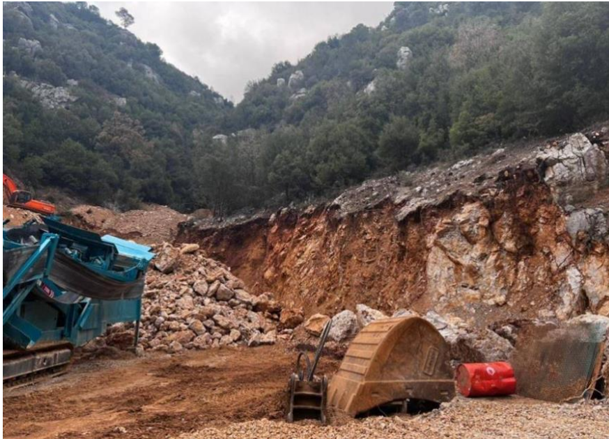
Figure 31 Élargissement de la route de Wadi El Jamajem. Source : TERRE Liban
