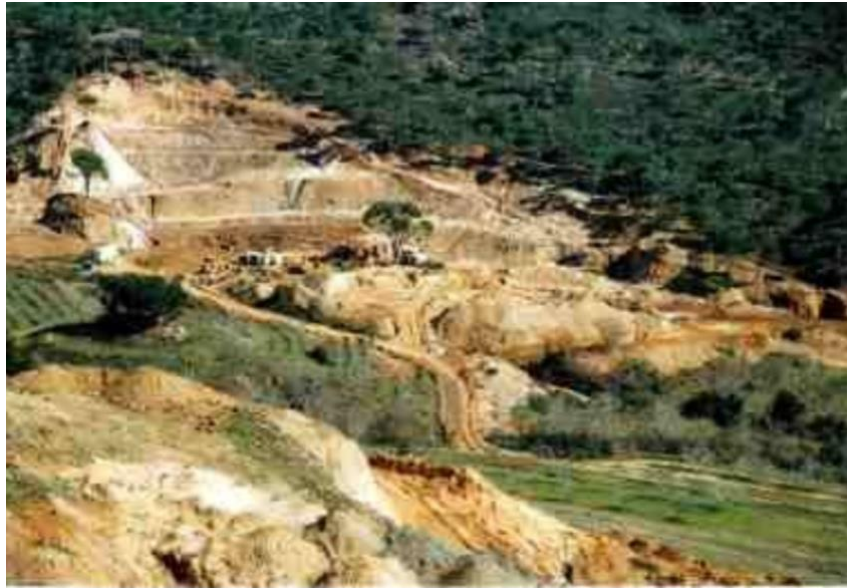
Figure 30 Vue des carrières de Mayrouba. Source : TERRE Liban
