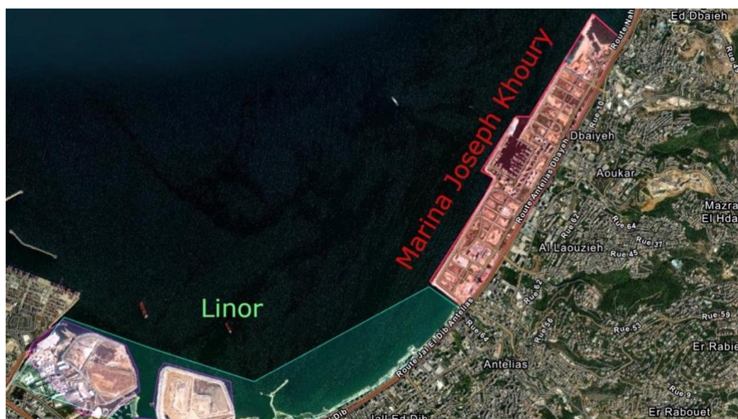
Figure 6 photo satellite montrant l'emplacement du projet Linor et la Marina Dbayeh
