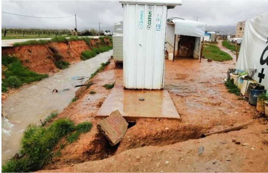
Figure 16 WC et fosses septiques mis en place par Oxfam. Source Office National du Litani
