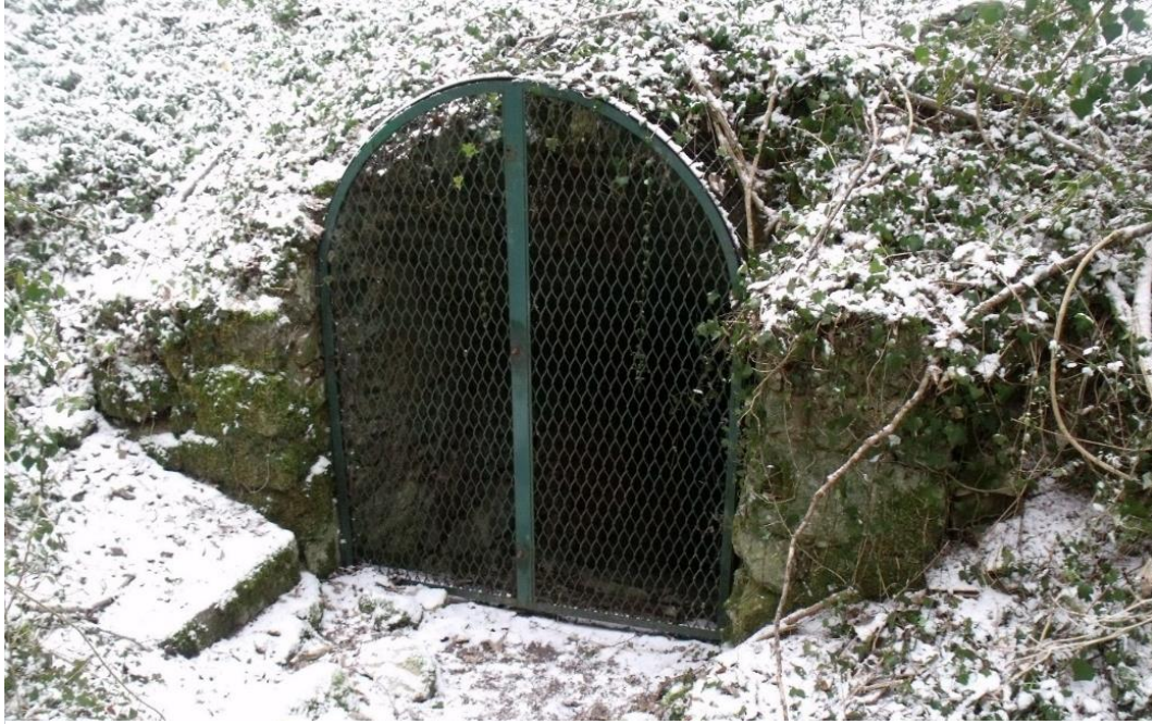
Figure 22 : Entrée de la cave de la commanderie templière de Beauvais-en-Gâtinais (source : S. DAVID, 2018)
