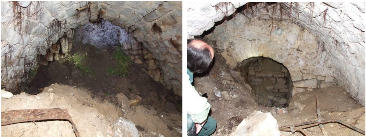
Figure 123 : Cave de l'ermitage de Franchard découverte lors d'un entraînement des pompiers (source : ONF, C. Dardignac, 2014)
