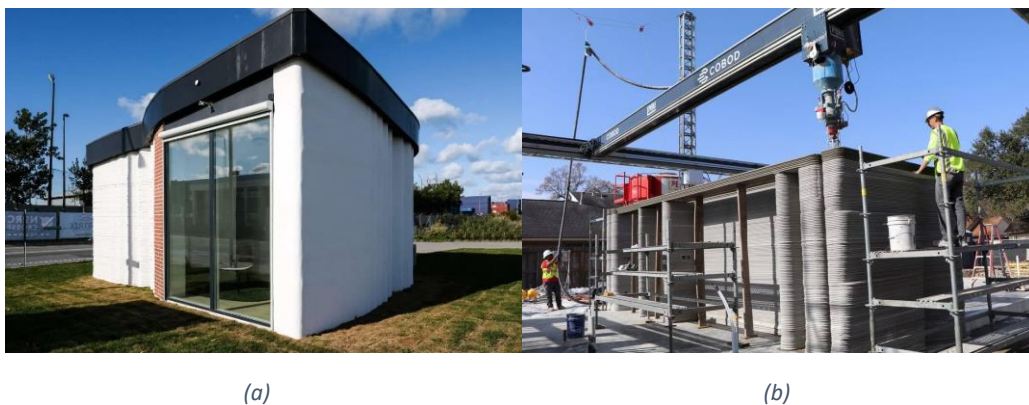
Figure 1.4: (a) Première bâtiment imprimé en Europe et (b) première maison à deux étages imprimée aux États-Unis par COBOD [20]
