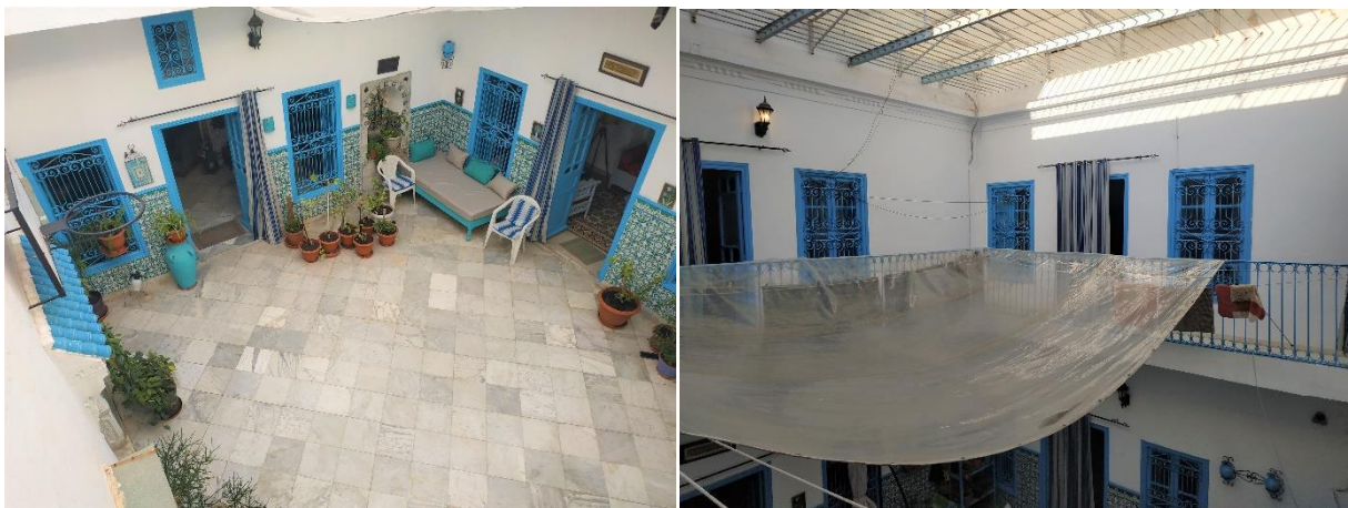
Figure 127 : Vue 4 & 5, vues sur le west el dar depuis le 1er étage, photos prises par Iman Batita le 20/01/2020 à Tunis
