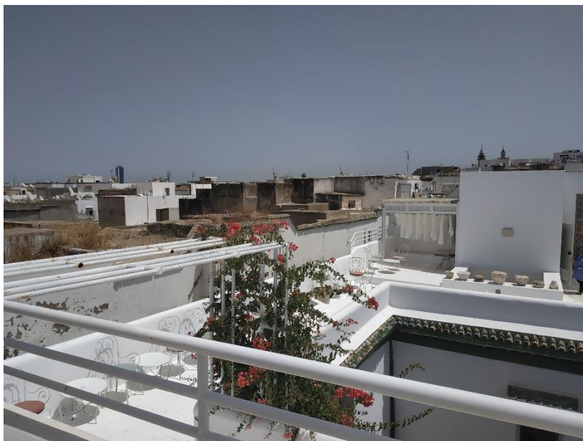
Figure 157 : Vue sur la toiture-terrasse aménagée, photo prise par Iman Batita le 18/07/2018 à Tunis
