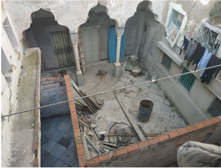
Figure 22 : Vue du 2e étage sur la cour, photo prise par Iman Batita le 22/01/2020 à Tunis
