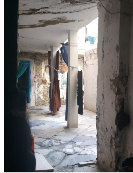
Figure 61 : Vue 1 : Espace collectif du rez-de-chaussée, photos prises par Iman Batita, le 22/01/2020 à Tunis
