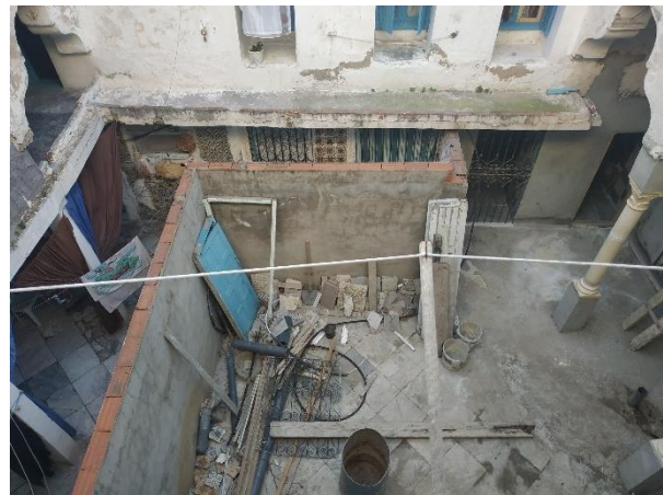
Figure 64 : Vue du 2e étage sur la cour, photo prise par Iman Batita le 22/01/2020 à Tunis
