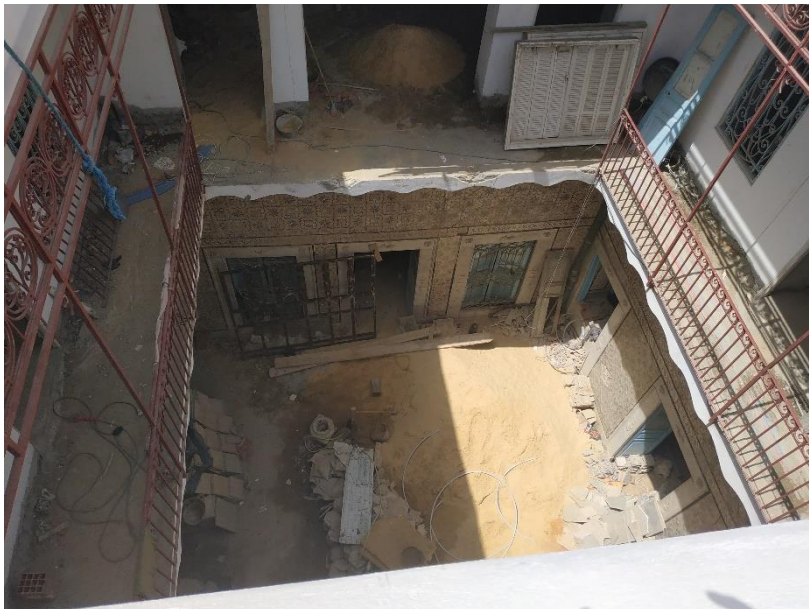
Figure 158 : Vue sur le west el dar de la seconde chambre d'hôtes en chantier, photo prise par Iman Batita le 18/07/2018 à Tunis
