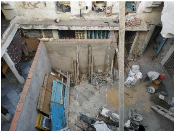
Figure 64 : Vue du 2e étage sur la cour, photo prise par Iman Batita le 23/07/2018 à Tunis
