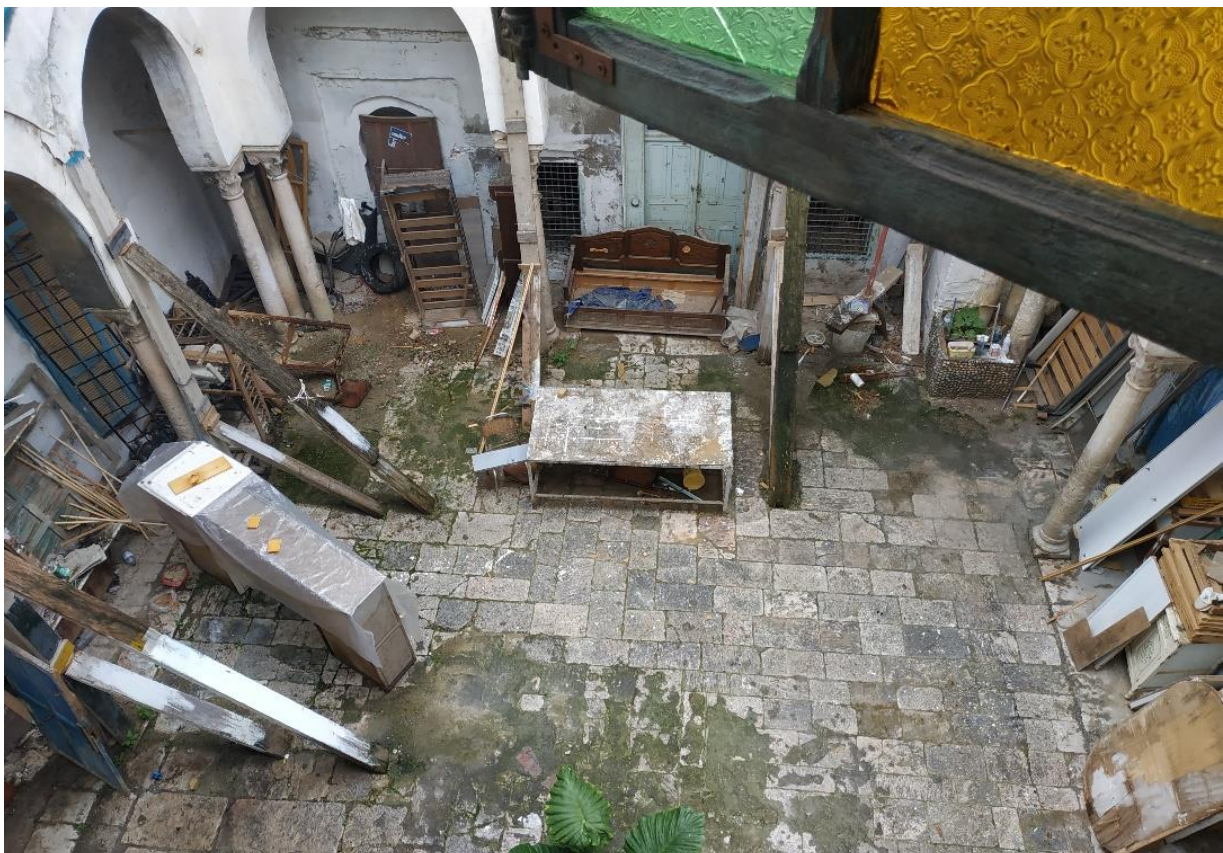
Figure 114 : Vue 3, vue sur le west el dar anciennement oukalisé à partir du 1er étage, photo prise par Iman Batita le 12/01/2020 à Tunis
