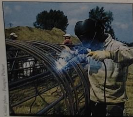
Les pourvoies de chantiers menent vers le ciel de
