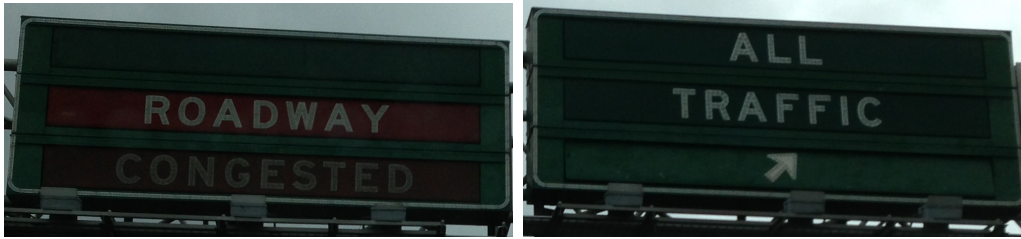
FIGURE 1.6 – L'un des premiers panneaux à message variable (PMV) sur la Turnpike du New Jersey dans les années 1950. Les panneaux à message variable étaient les premiers outils permettant de gérer le choix de l'itinéraire en temps réel sans avoir besoin d'un agent de police de la circulation ou de panneaux routiers temporaires. De nos jours, nous envisageons que les panneaux à message variable seront à terme remplacés par des applications de navigation ou tout autre dispositif connecté.
