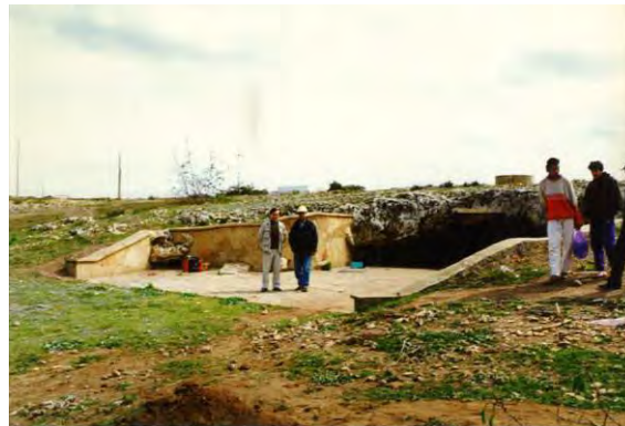
Figure 110 : Grotte d'El Mnasra de Témara en 1996, avant les travaux d'aménagement urbain au-dessus de la grotte (Photo Lacombe)
