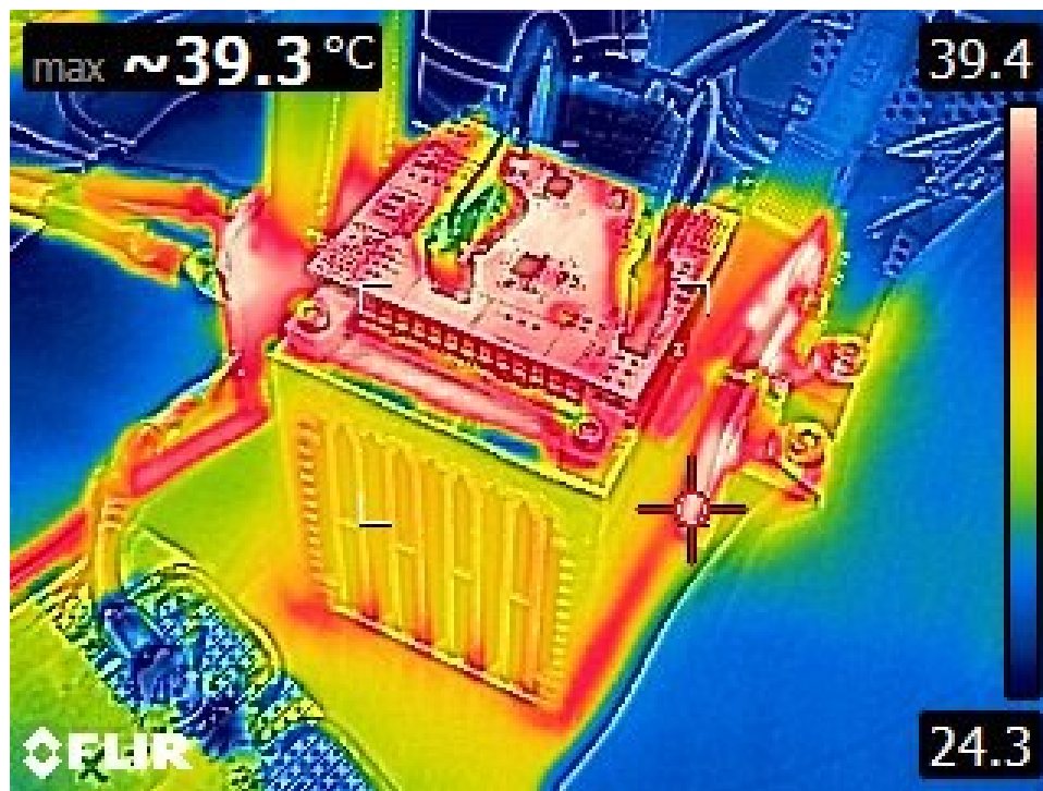
Fig. VI.19 : Mesure d'échauffement de l'électronique de puissance.
